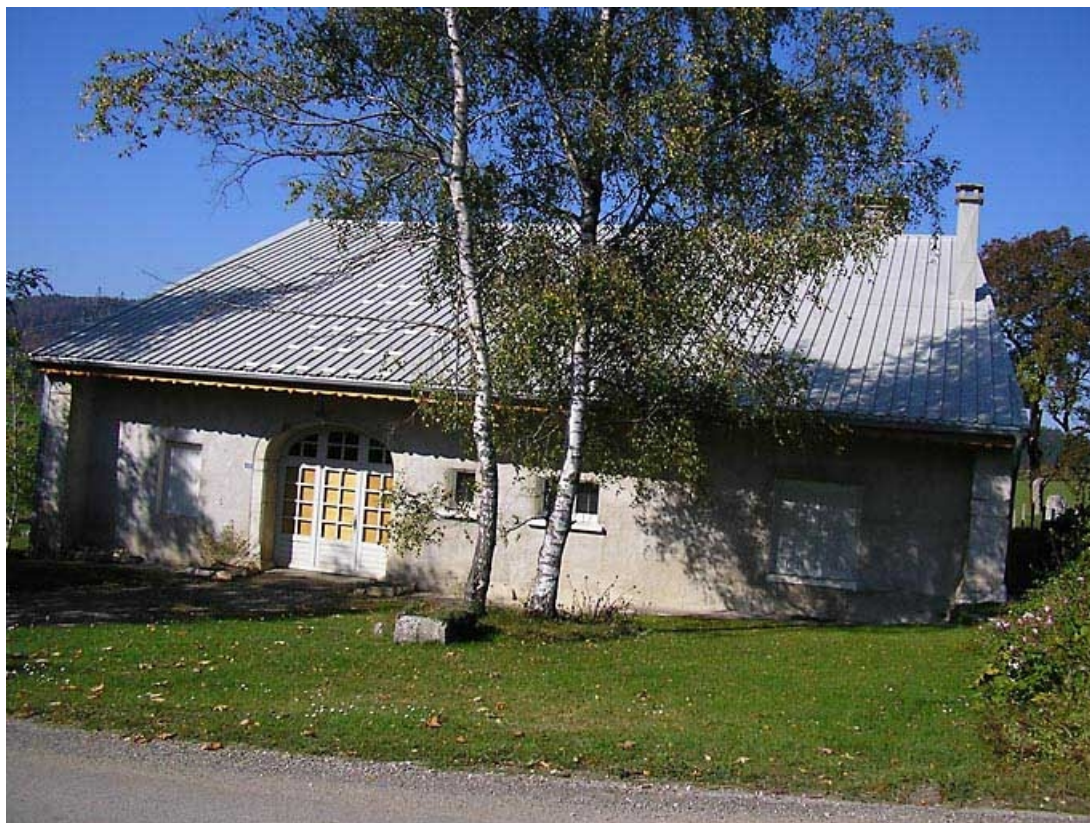
Vue latérale de la façade postérieure.
