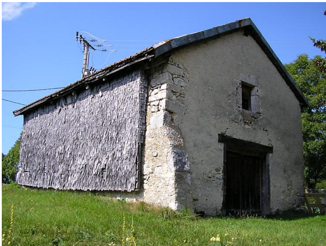
Façade antérieure et le pignon sud-ouest vus de trois quarts.
