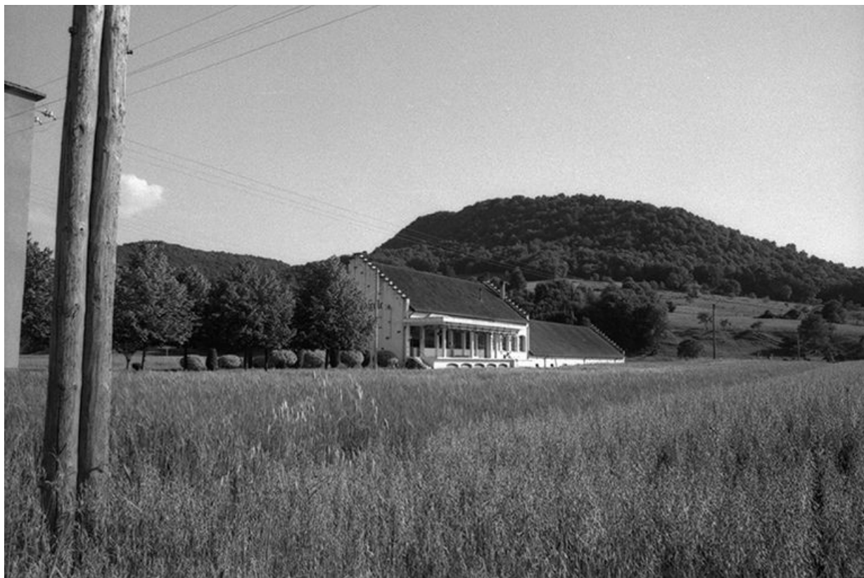
Coopérative vinicole située le long du chemin départemental n° 70 de Lons-le-Saunier à Voiteur : vue d'ensemble. 39, Voiteur
