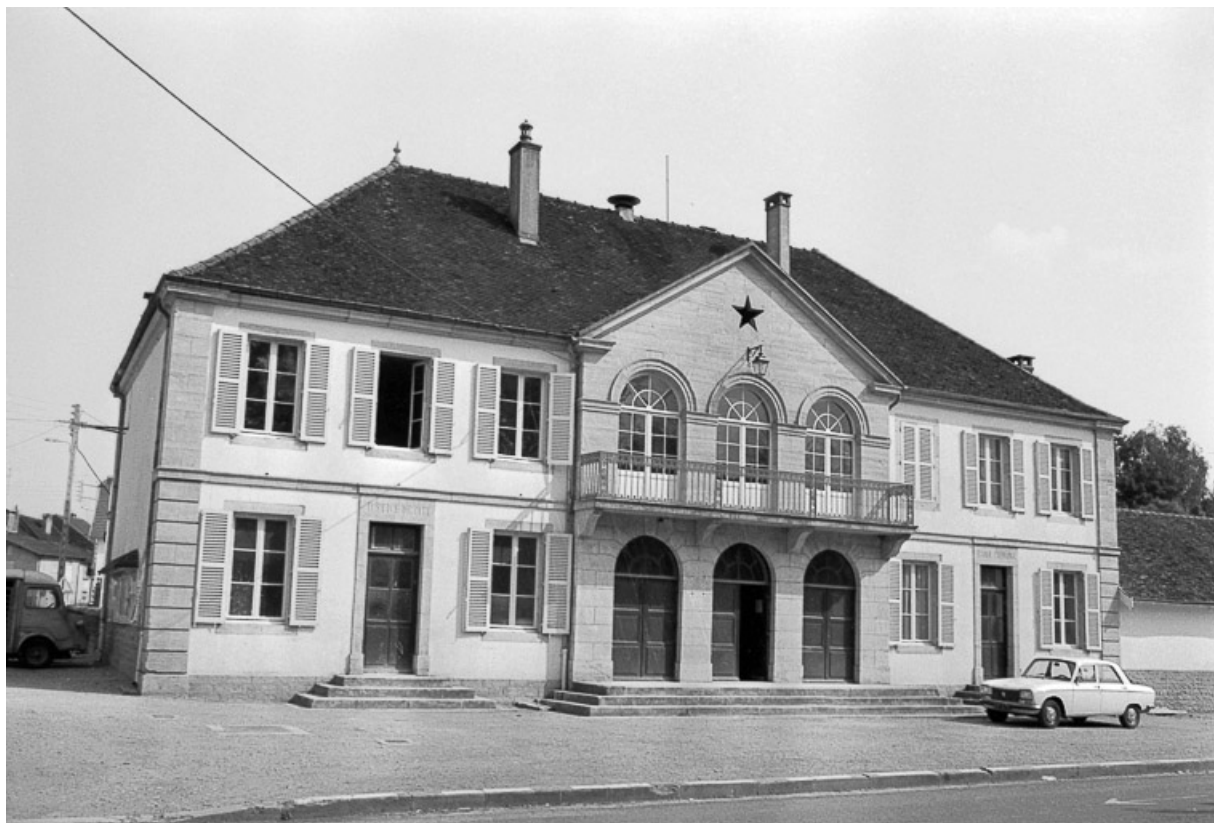
Façade sur rue. 39, Voiteur
