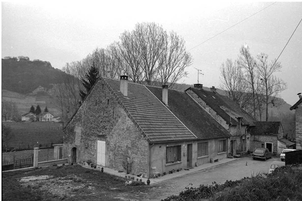
Maisons cadastrées 1961 AH 72, 73, 77, situées au lieudit Champ Louvent : façades antérieures 39, Voiteur
