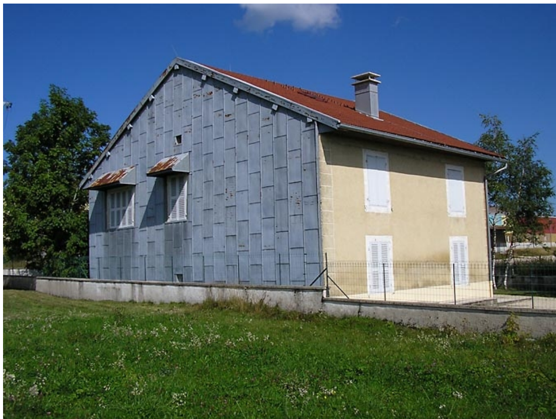
Pignon sud-ouest et façade latérale vus de trois quarts. 39, Saint-Pierre
