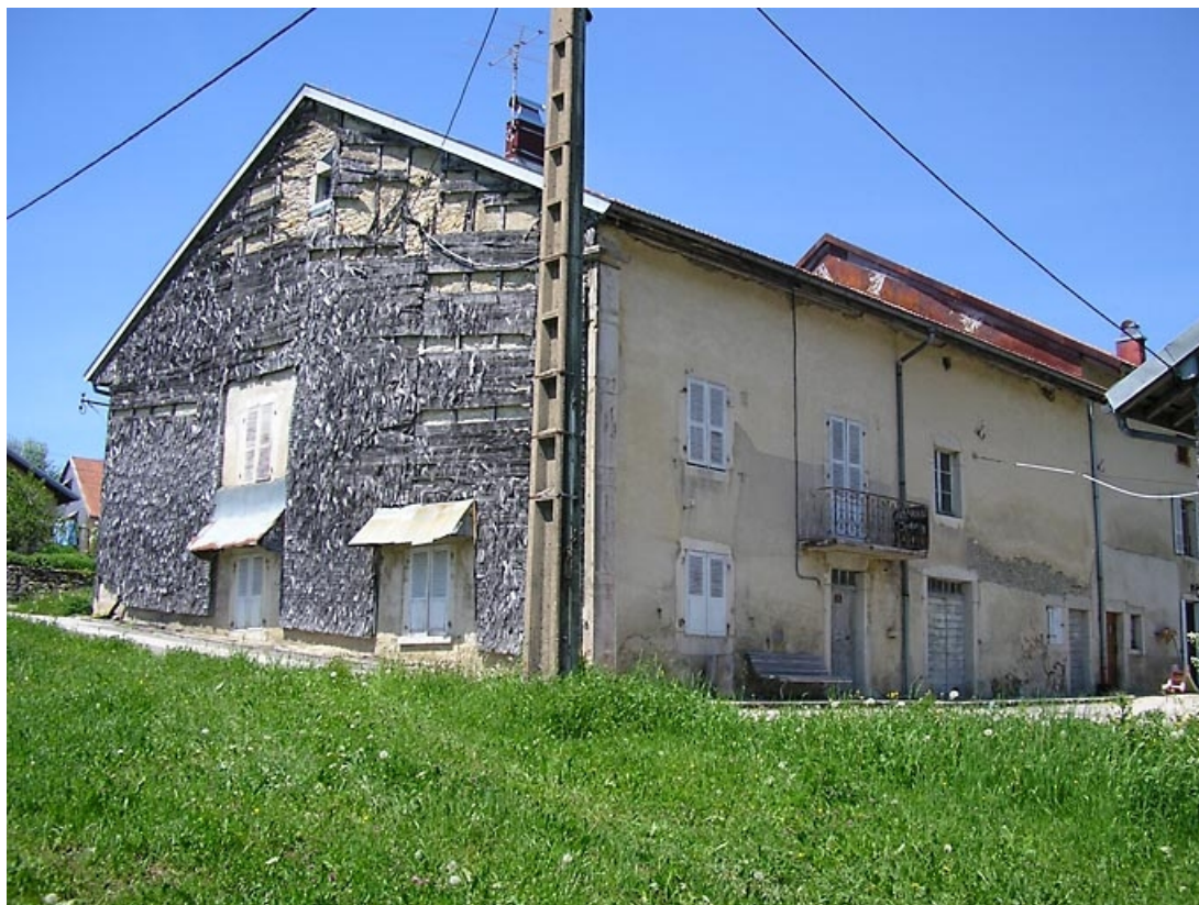
Pignon sud-ouest et façade antérieure vus de trois quarts.
