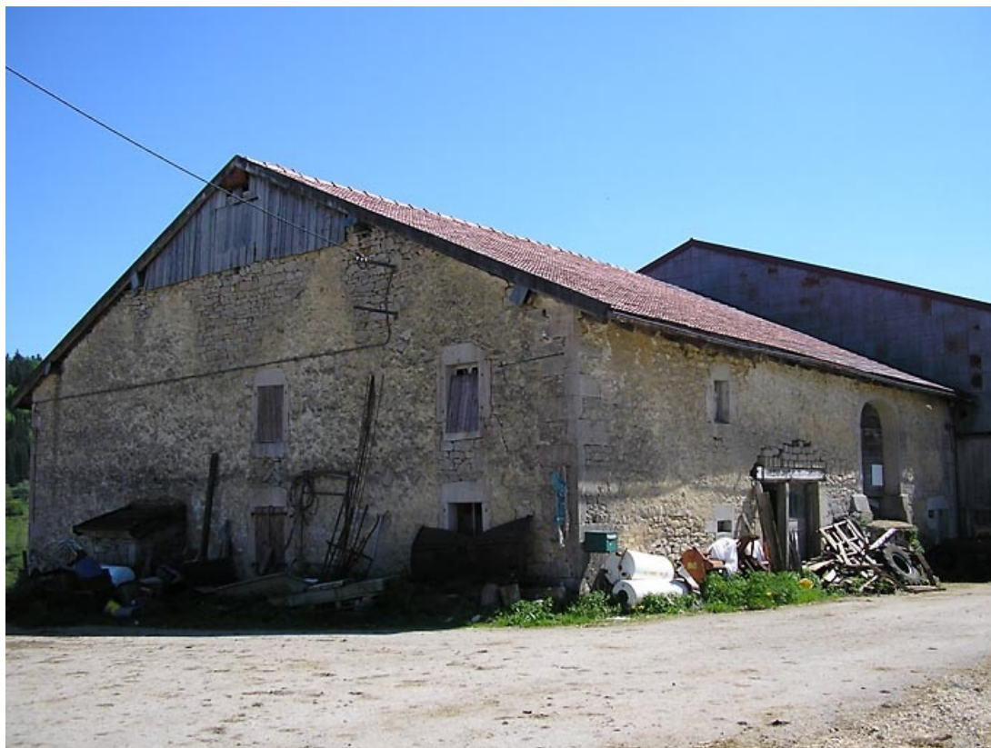
Façade postérieure et pignon essenté vus de trois quarts.
