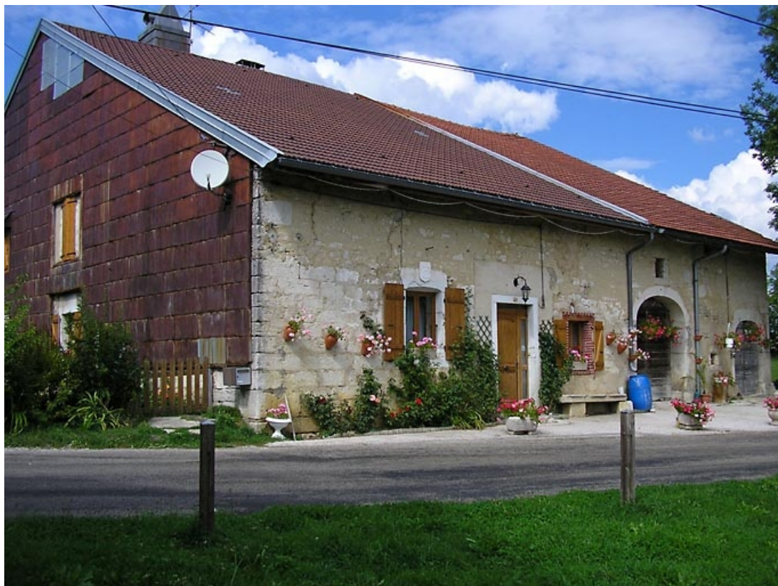
Façade antérieure et pignon sud-ouest vus de trois quarts. 39, La Chaumusse
