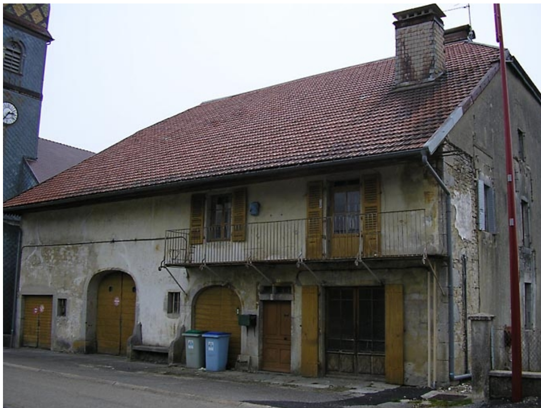
Vue de trois quarts sur façade antérieure.
