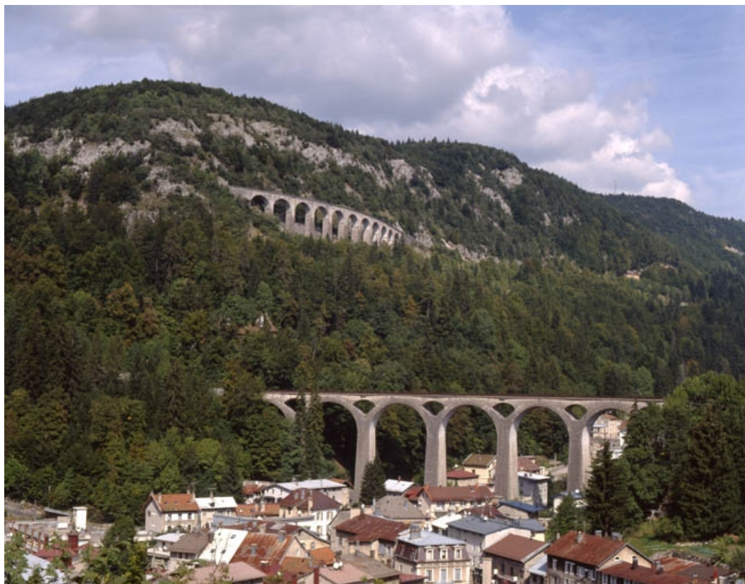
Le bas de la ville, le viaduc et la vallée de l'Evalude. Montagne et viaduc des Crottes en arrière-plan. 39, Morez
