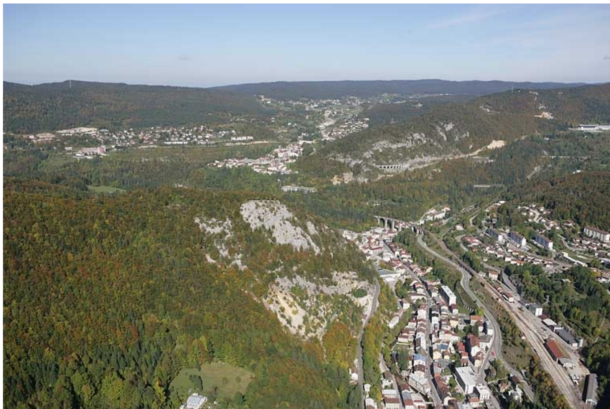
Vue aérienne du bas de la ville et du confluent de la Bienne et de l'Evalude, depuis le sud. 39, Morez
