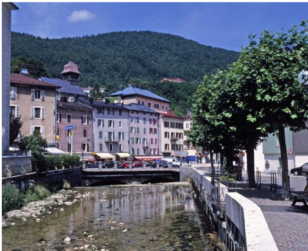
Vue d'ensemble, depuis la rive droite en amont.
