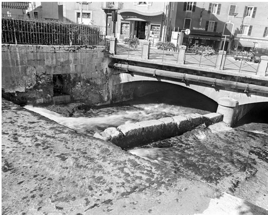
Seuil et muret précédant la pile. Noter dans le mur gauche le débouché du canal et celui de l'égout (sous l'arche). 39, Morez rue de la République
