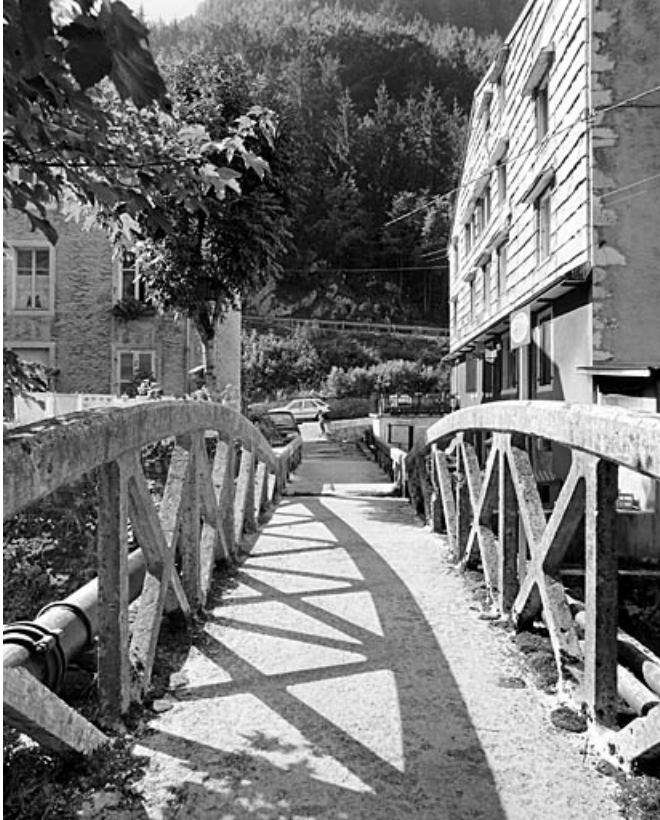
Tablier et garde-corps, depuis la rive droite. 39, Morez rue Emile Zola
