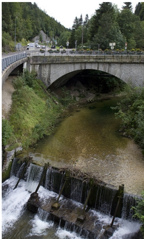
Pont des Douanes : vue d'ensemble, depuis la rive gauche en aval. 39, Morez
