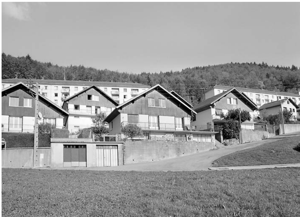
Maisons 34 à 38 avenue de la Libération : élévation sud-ouest. Maisons de 1965-1969.
