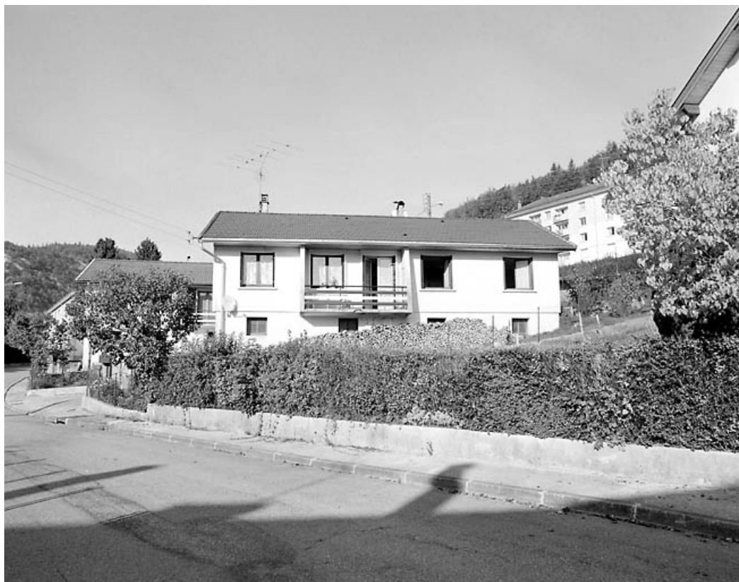
Maison 3 rue de la Die : élévation sud. Maison Duboin type F6 (variante), de 1958-1959.
