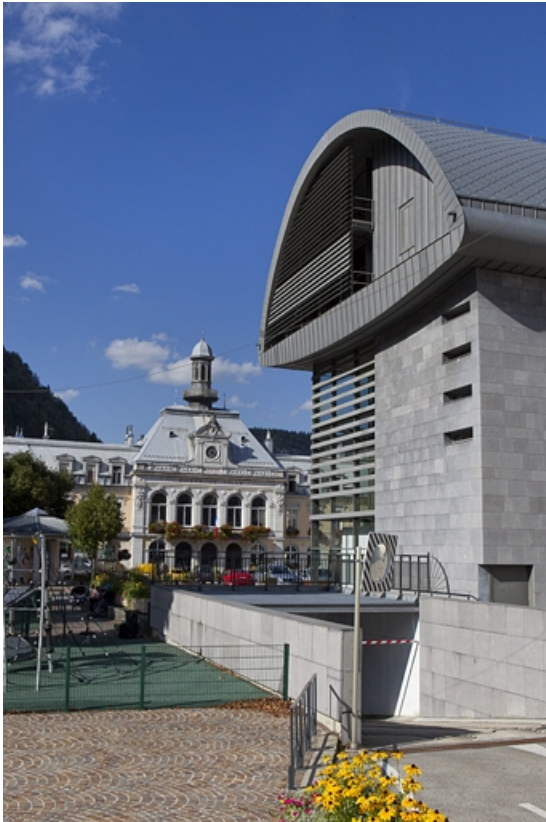
Façade latérale droite.
