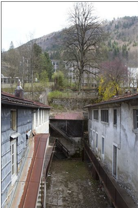
Immeuble avec atelier (18e siècle) au n° 161 rue de la République : murs de soutènement des jardins. 39, Morez, 161 rue de la République
