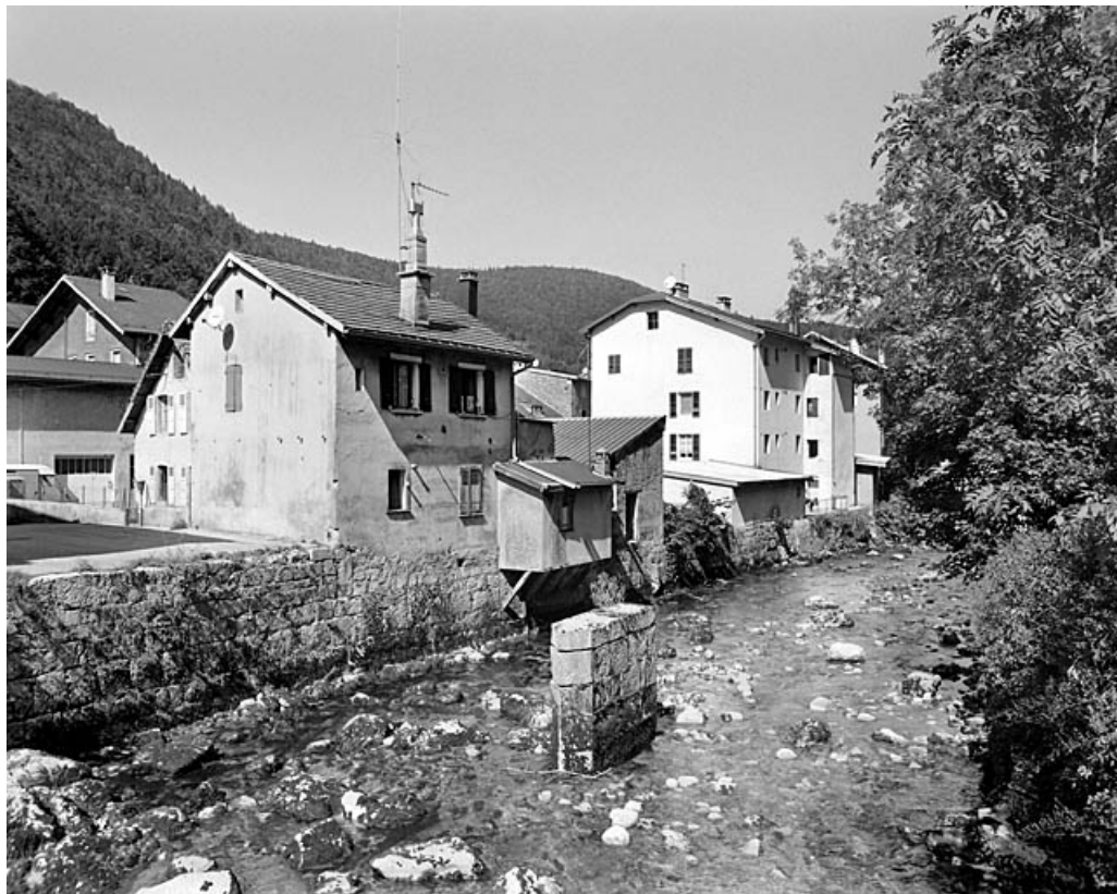
Vue d'ensemble, depuis le sud-est : élévations postérieures.
