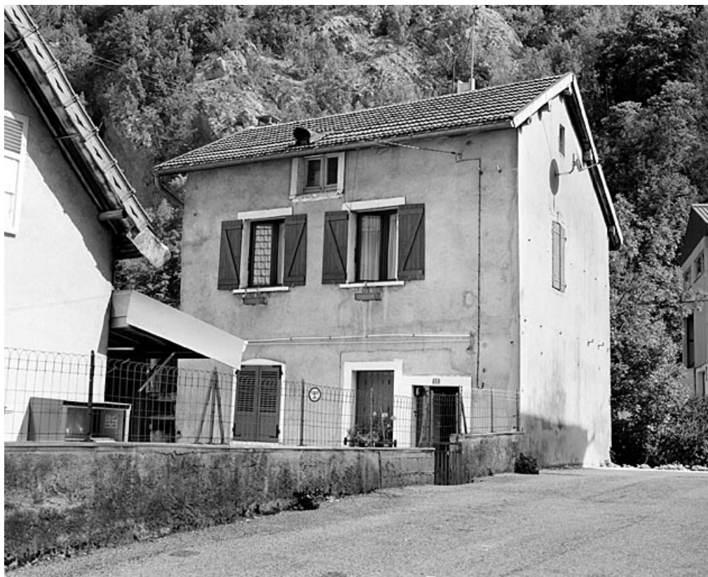
Maison au n° 13 : élévation antérieure, de trois quarts droite.
