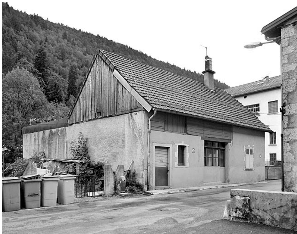
Maison au n° 11 : élévation antérieure, de trois quarts gauche.
