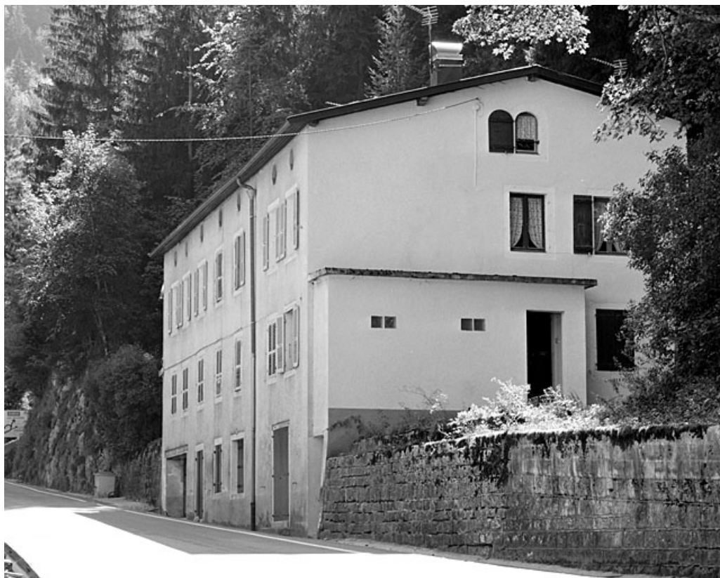
Façades antérieure et latérale droite.
