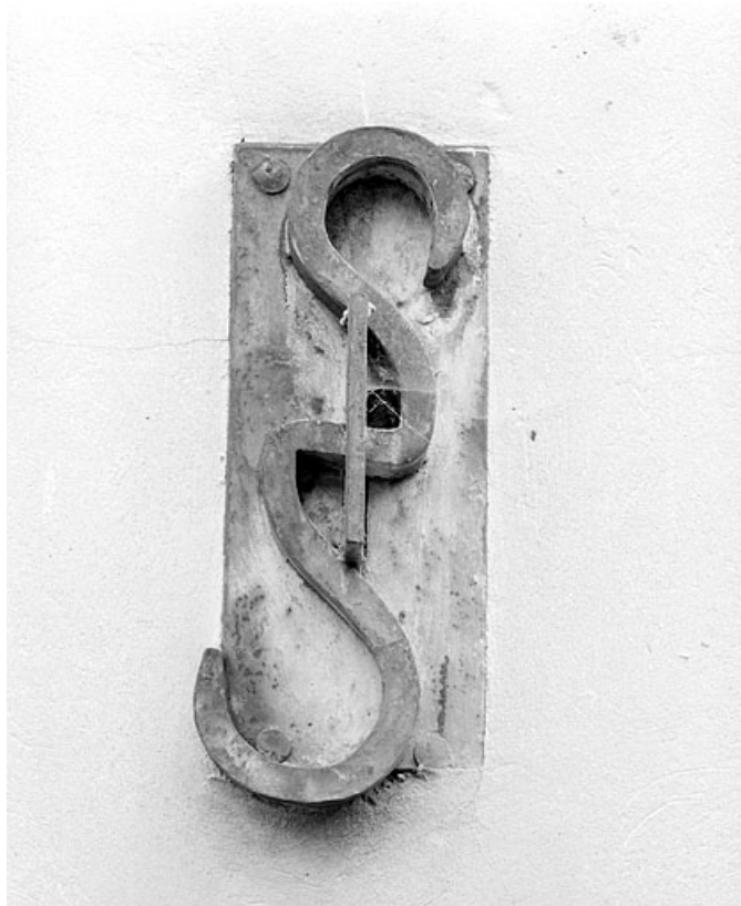
Immeuble : ancre en S sur le mur pignon occidental.
