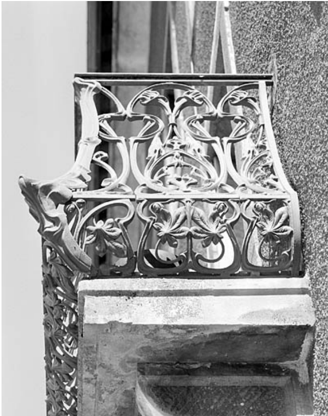
Balcon de l'immeuble : détail du garde-corps.
