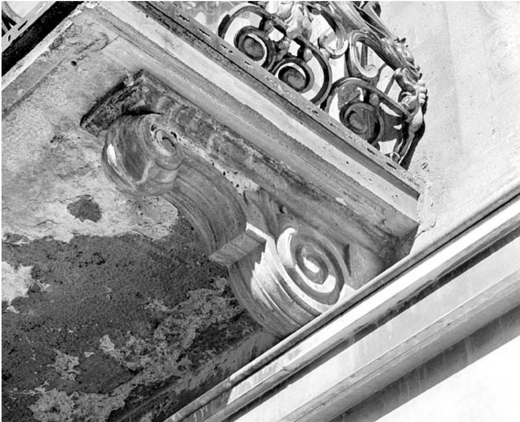
Balcon : détail d'une console.
