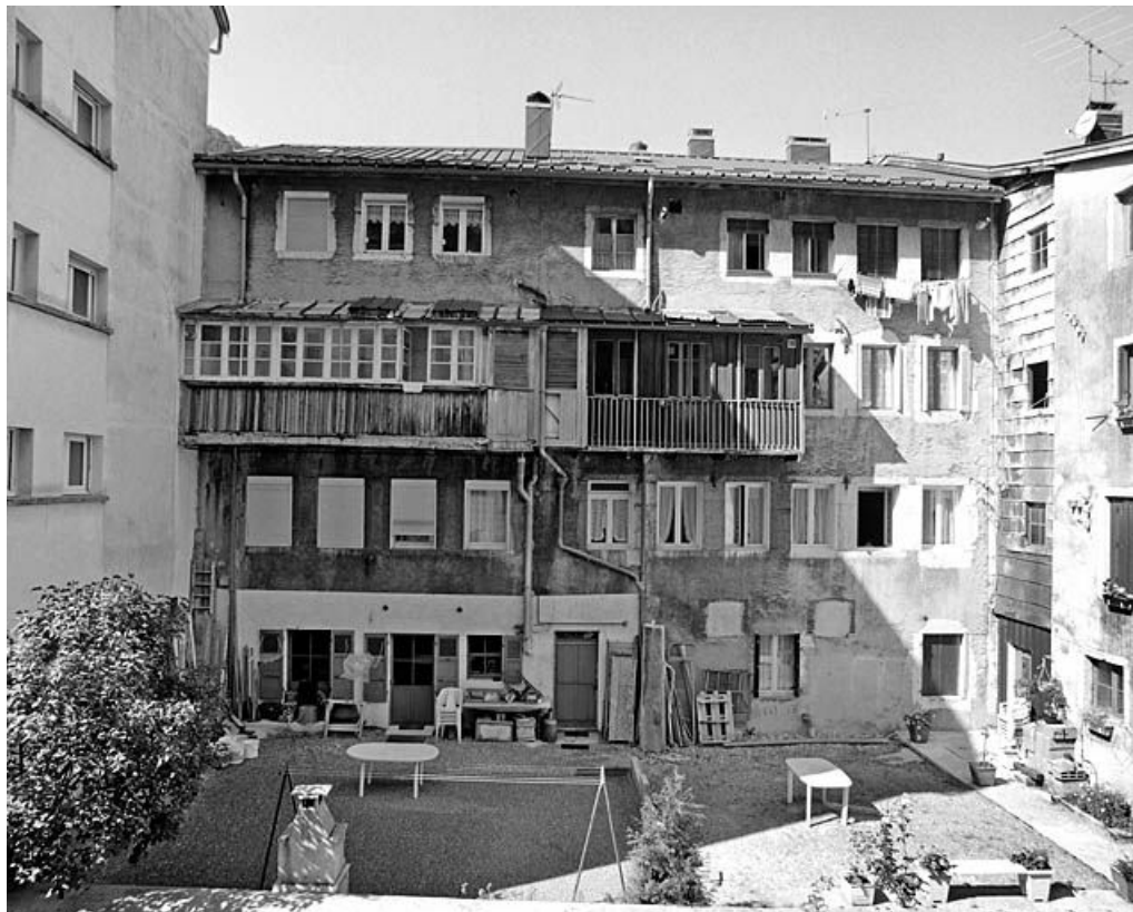
Ancien moulin à farine et martinet Clément (19 à 23 rue du Docteur Regad) : élévation côté Bienne. 39, Morez, 19 à 23 rue du Docteur Regad
