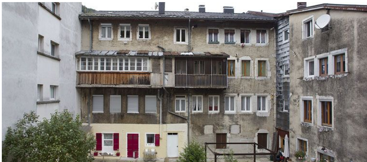
Bâtiments aux n° 19 et 23, vus de l'est (côté Bienne).
