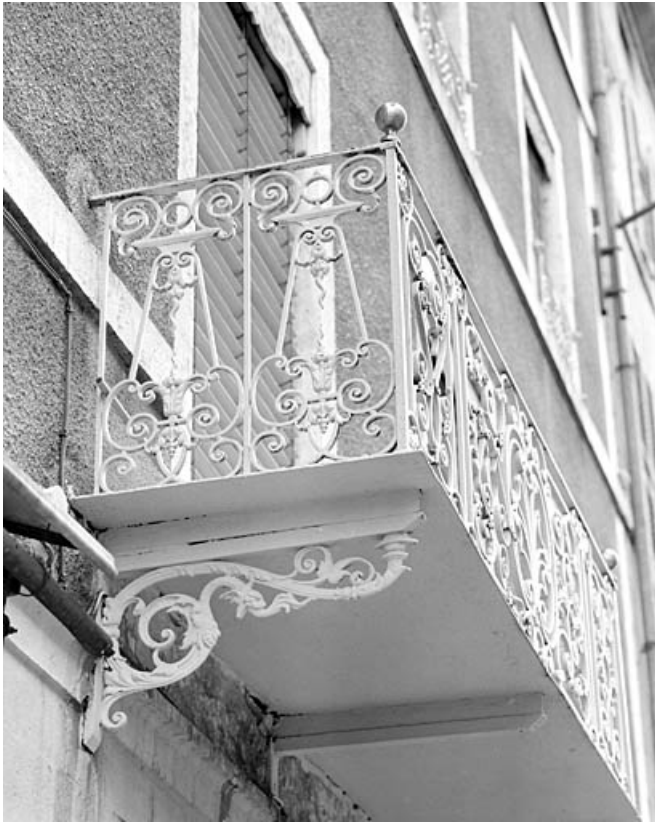
Balcon du premier étage : garde-corps et console.
