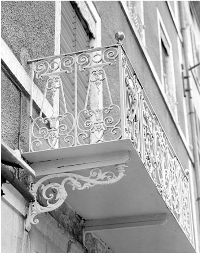
Balcon du premier étage : garde-corps et console.
