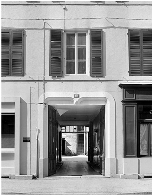
Entrée principale (passage couvert) et fenêtre du premier étage.
