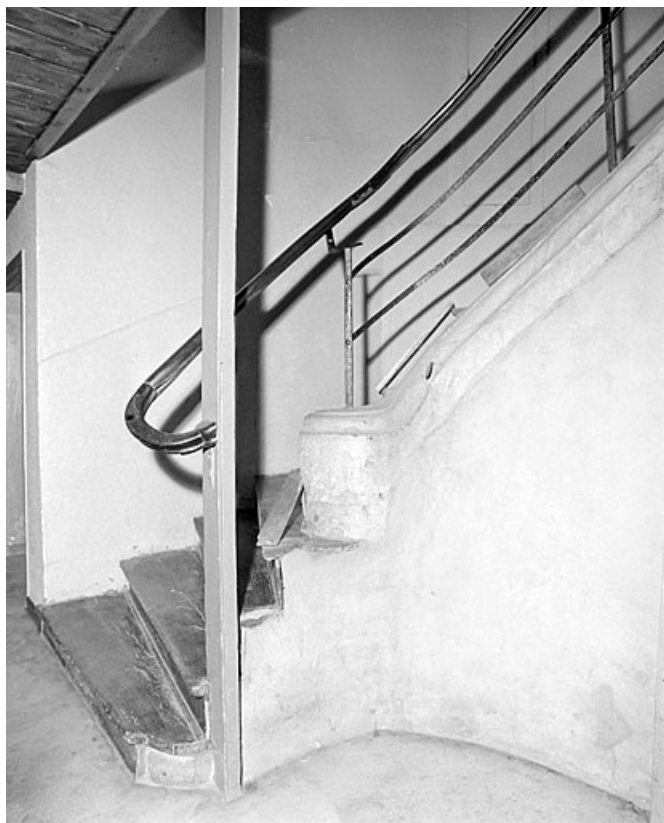
Escalier tournant : première volée.
