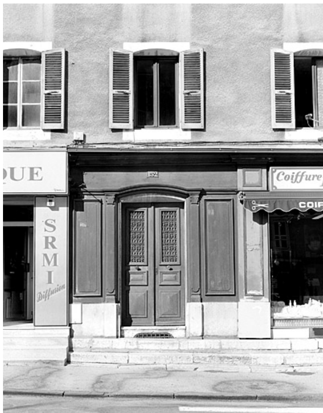
Élévation antérieure : porte principale et fenêtre du premier étage. Ces baies ont un linteau délardé en arc segmentaire. 39, Morez, 152 rue de la République
