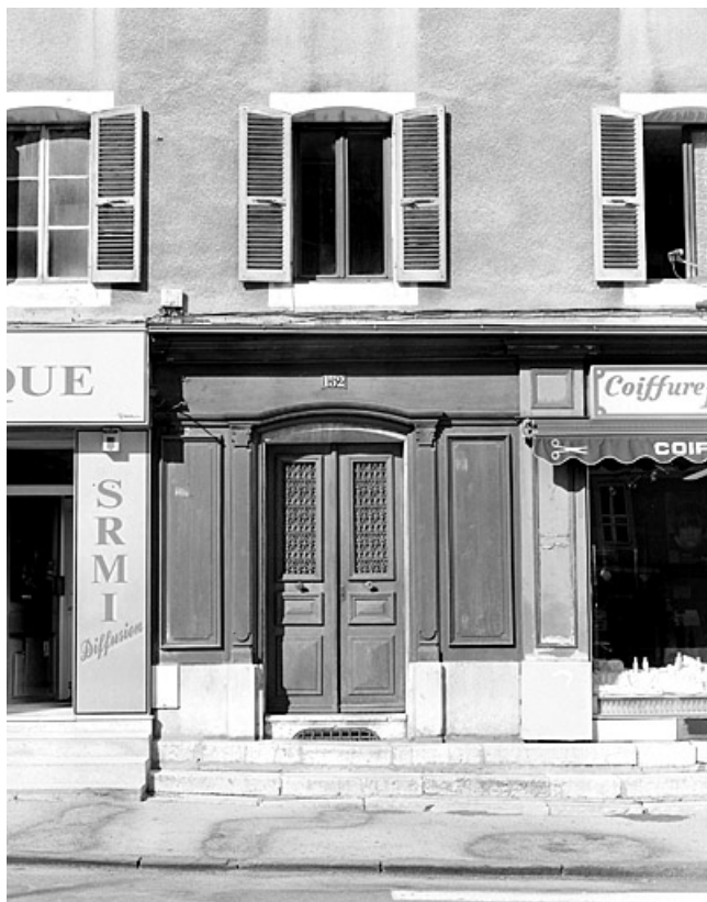
Élévation antérieure : porte principale et fenêtre du premier étage. Ces baies ont un linteau délardé en arc segmentaire. 39, Morez, 152 rue de la République
