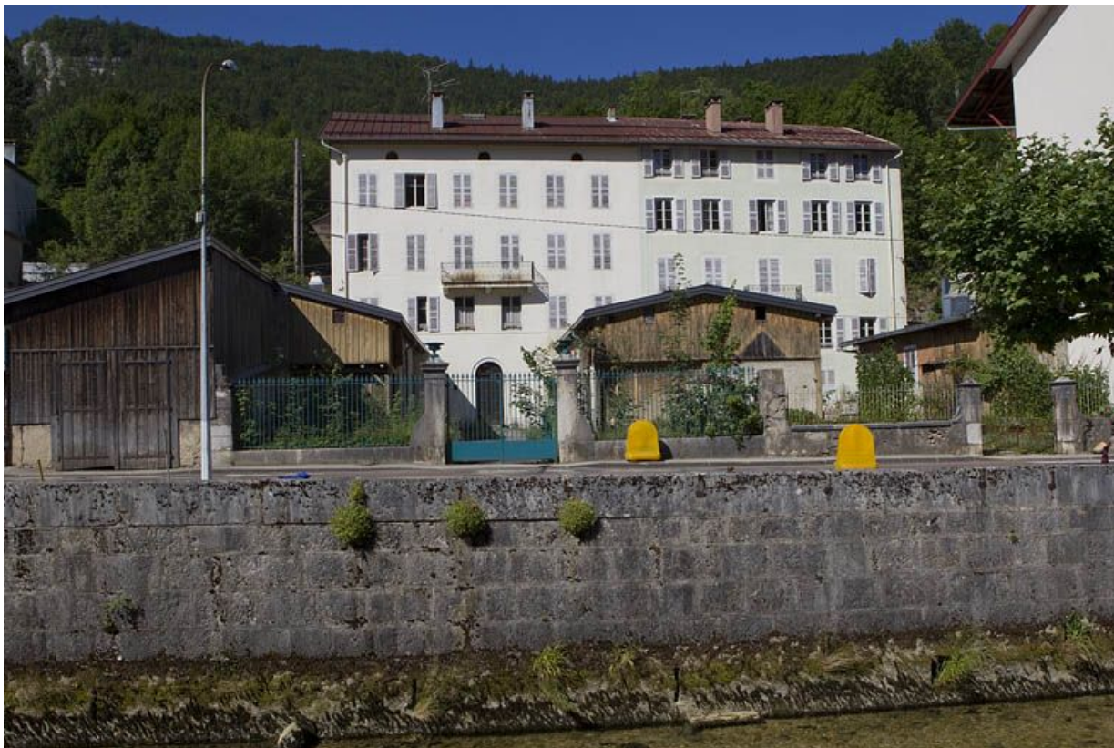
Immeubles (19e siècle) aux n° 3 et 5 rue Pasteur : élévation postérieure (donnant sur les n° 30 à 34 quai Jobez). Immeubles (AI 20 et 21) bâtis vers 1875. Celui de droite (au n° 3) comptait un atelier.
