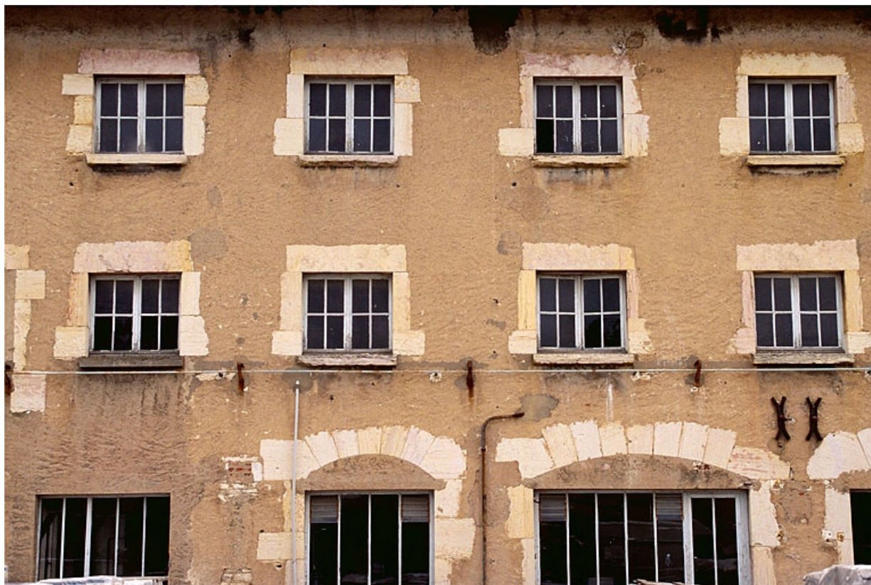
Détail de la façade de l'atelier (27), depuis l'ouest.
