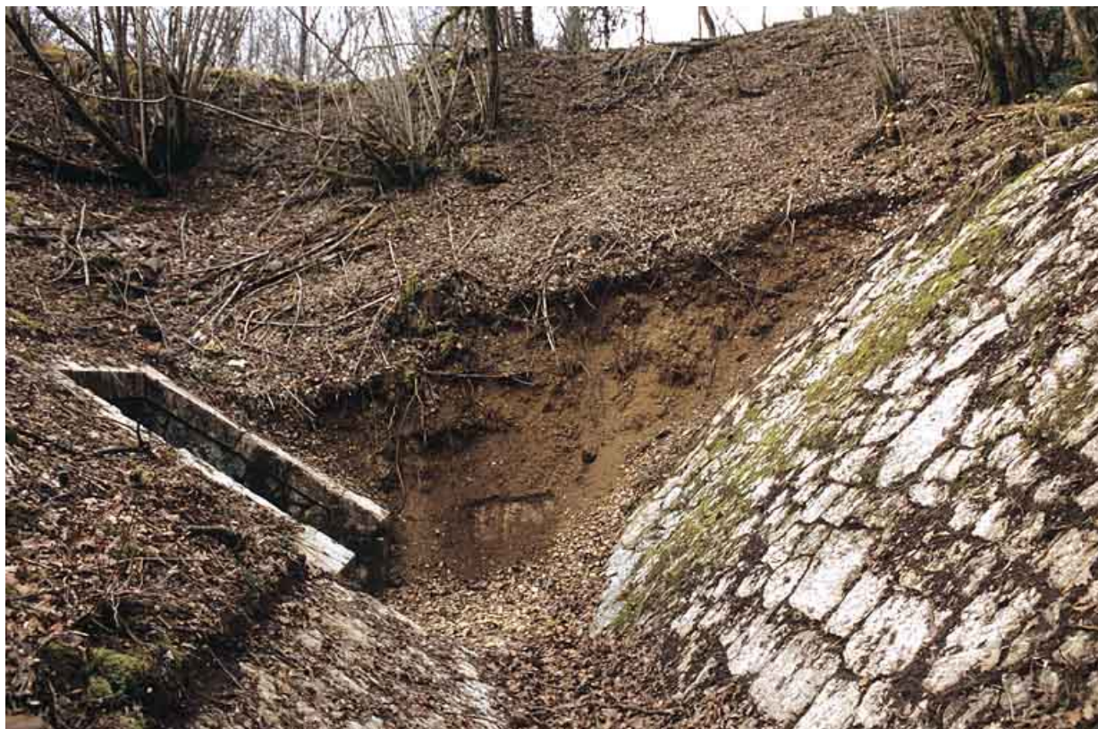
Aqueduc : " canal " et tête amont.
