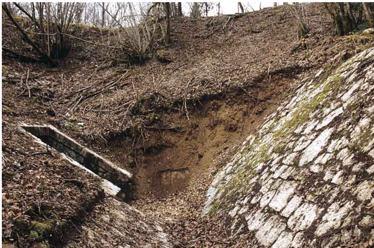
Aqueduc : " canal " et tête amont.
