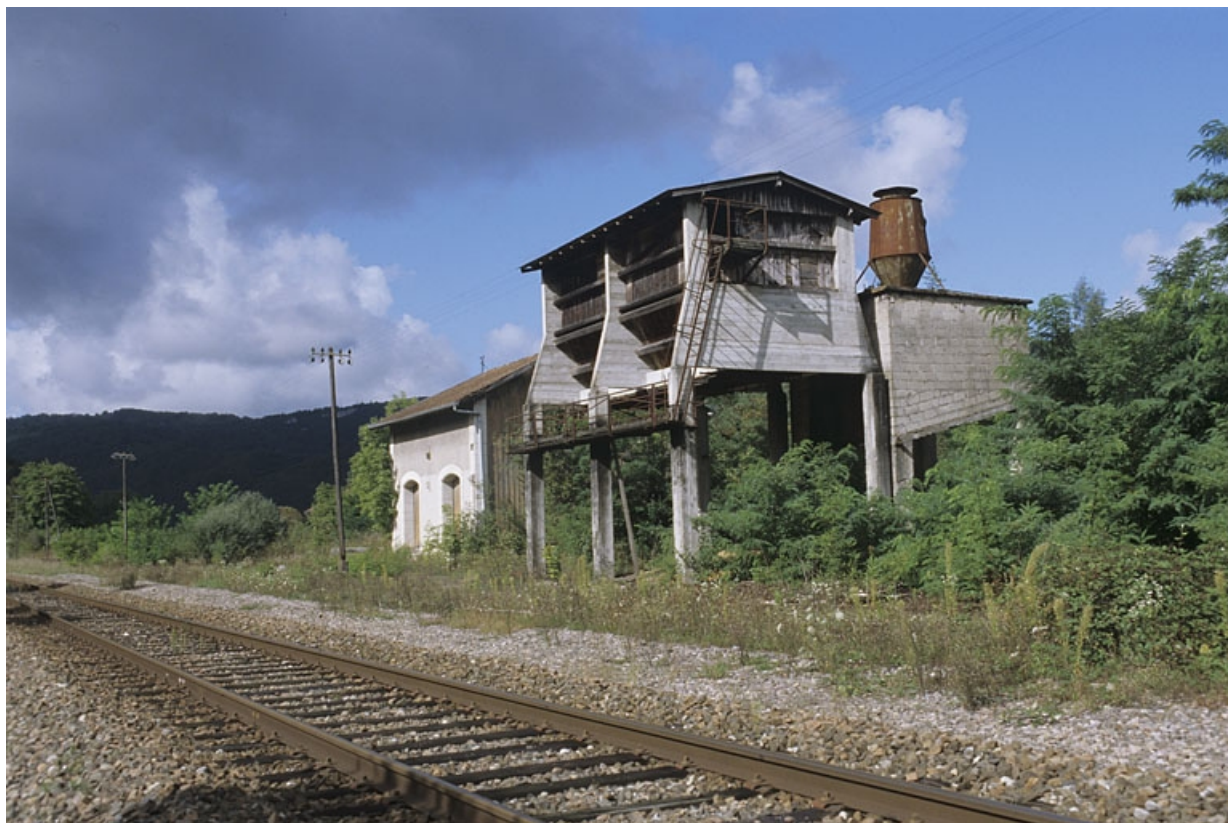
Entrepôt et silo à sciure, depuis la voie côté Andelot-en-Montagne (nord-est). 39, Vaux-lès-Saint-Claude, lieudit : la Gare
