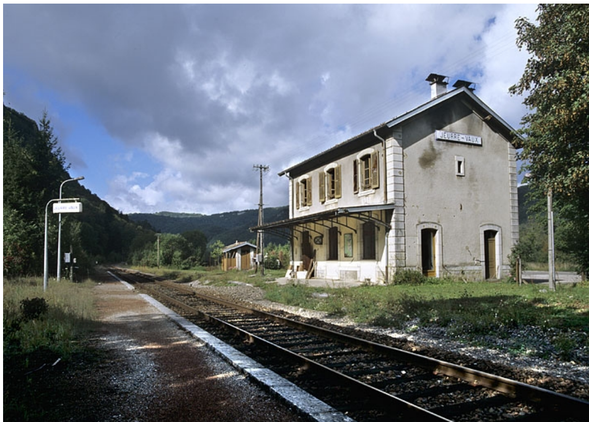
Bâtiment des voyageurs : façade postérieure, de trois quarts droite.
