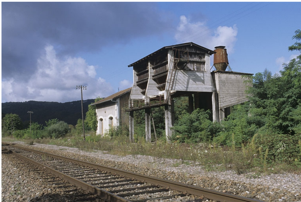
Entrepôt et silo à sciure, depuis la voie côté Andelot-en-Montagne (nord-est). 39, Vaux-lès-Saint-Claude, lieudit : la Gare
