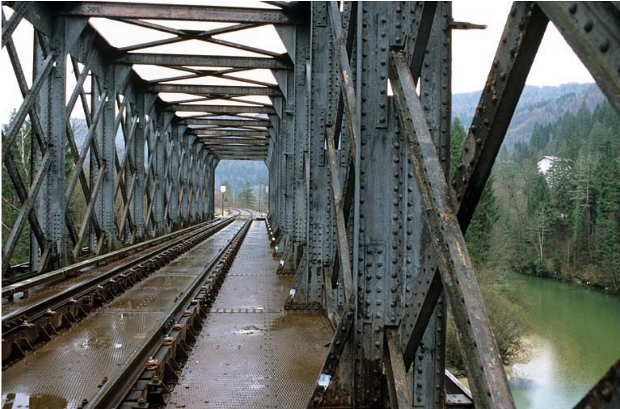
Charpente métallique, tablier et voie.
