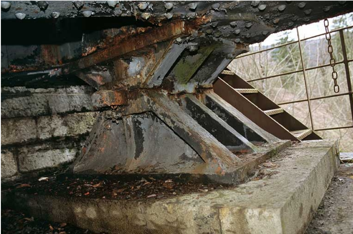
Appui fixe (extrémité côté La Cluse, à l'aval). 39, Chassal, lieudit : en Risoux
