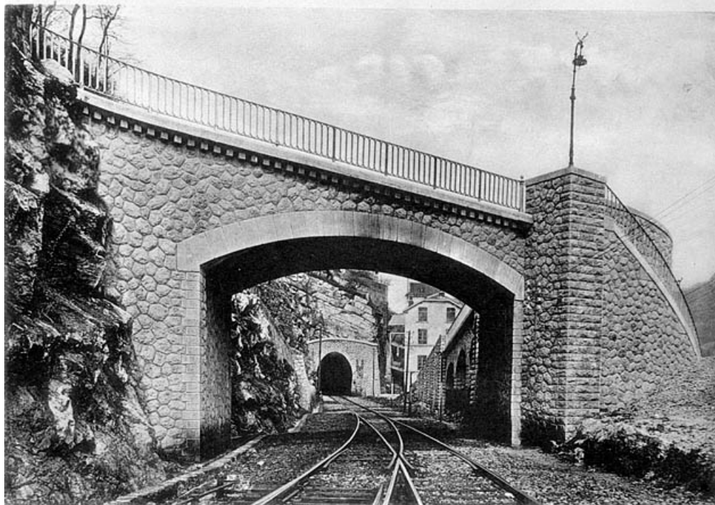
Passage supérieur voûté [...] Pt 238 H + 41 m, [1919].
