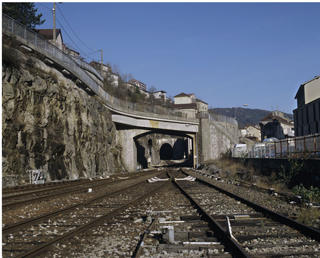
Vue d'ensemble, depuis le côté La Cluse (sud).
