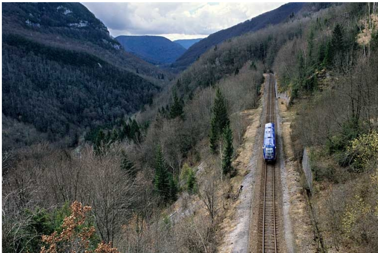
Voie ferrée à l'emplacement de l'ancienne station de Valfin, avec autorail X 73500, depuis le chemin surmontant la tête du tunnel côté La Cluse (sud).
