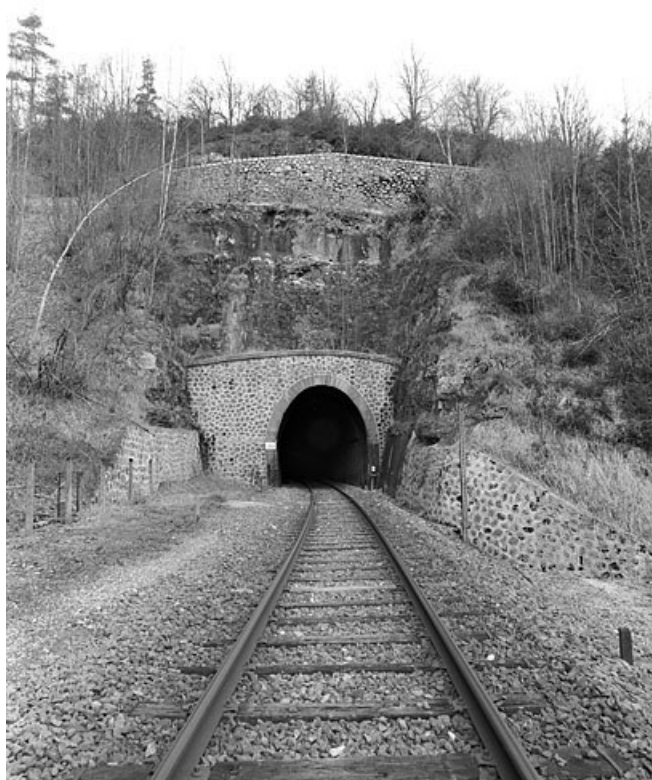
Tunnel : tête côté La Cluse (sud).
