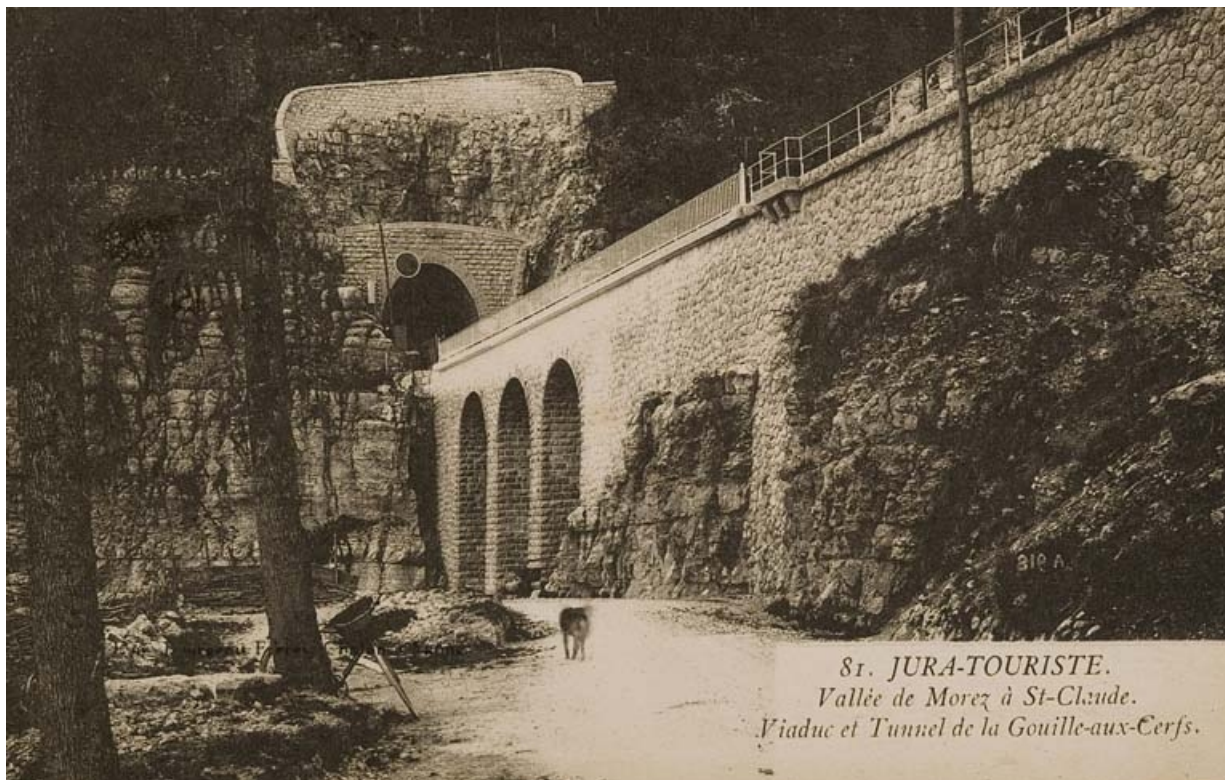
Vallée de Morez à St-Claude. Viaduc et Tunnel de la Gouille-aux-Cerfs, entre 1912 et 1924.
