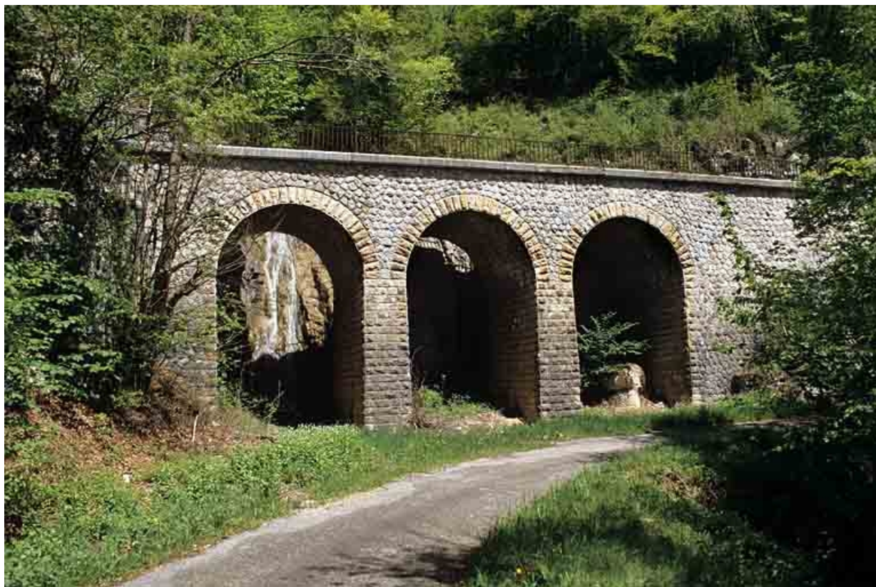
Viaduc, vu de trois quarts gauche.
