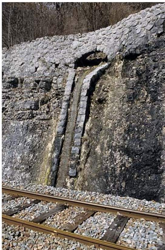
Descente d'eau dans le mur de protection à droite de la voie, de trois quarts droite.
