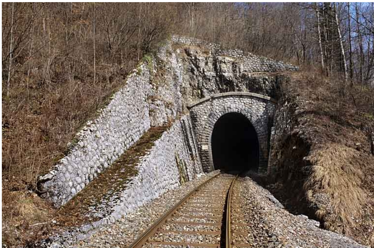
Tunnel du Chalet : vue d'ensemble, côté La Cluse (sud). À gauche, mur en aile sur deux niveaux. 65, Tancua, lieudit : la Côte
