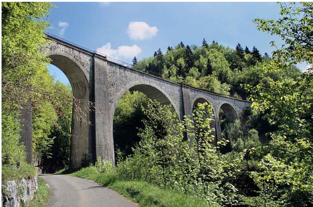
Élévation sud (aval), vue de trois quarts gauche.
