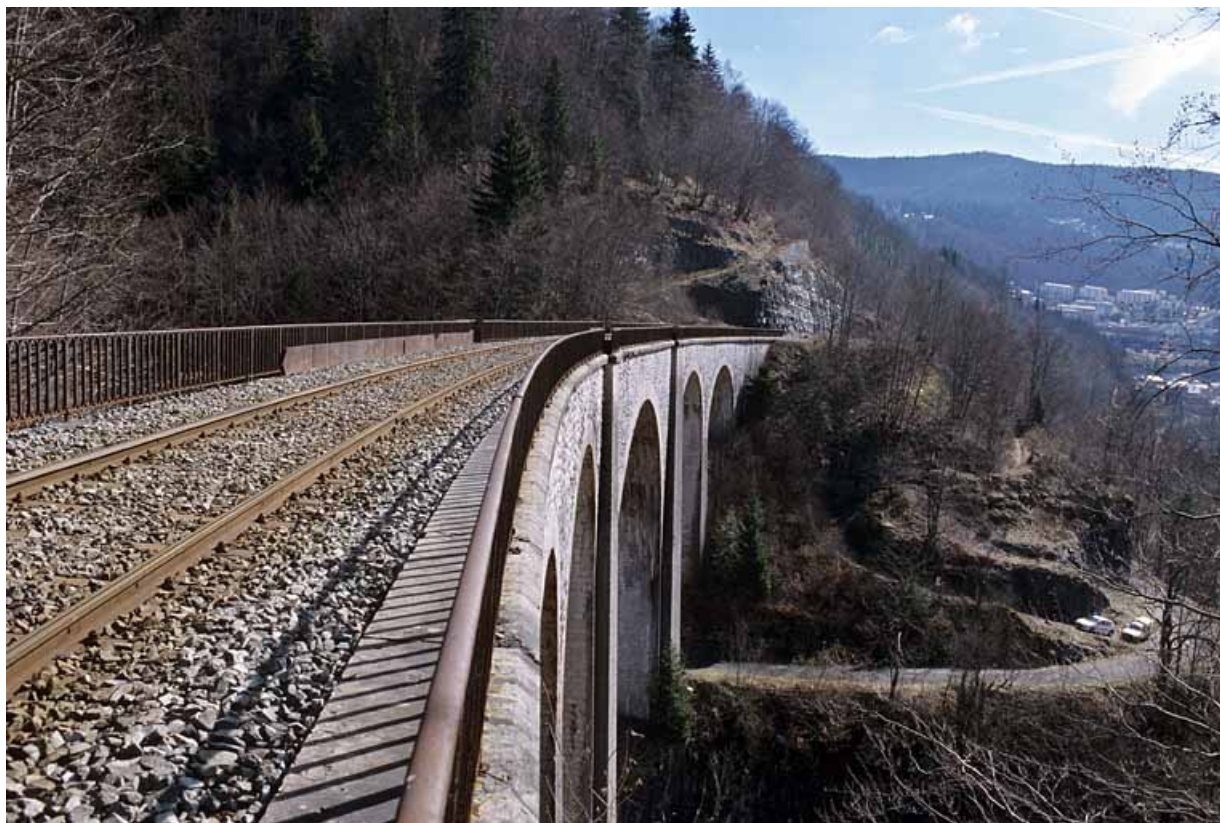
Vue d'ensemble en enfilade, depuis l'extrémité côté La Cluse (ouest).
