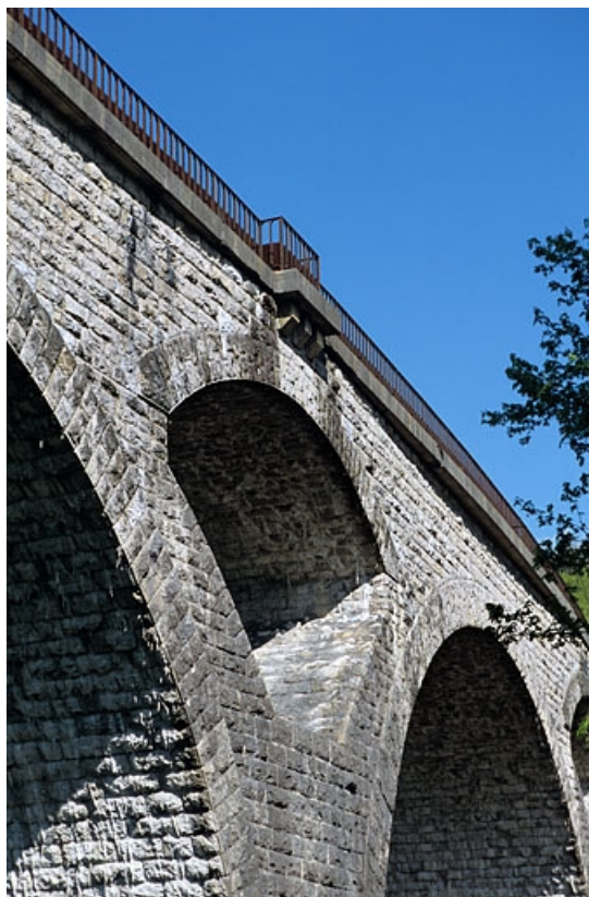
Voûte d'élégissement et refuge, vus de trois quarts. 39, Morez rue de la République
