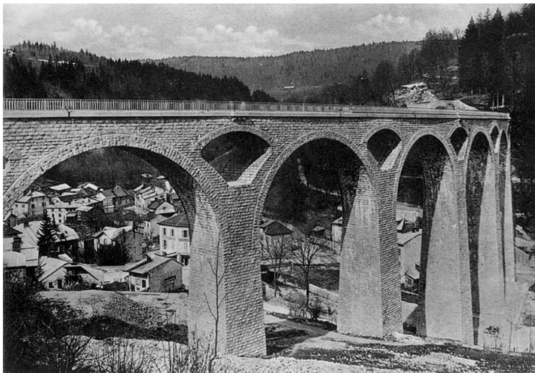
5. — VIADUC DE MOREZ.
