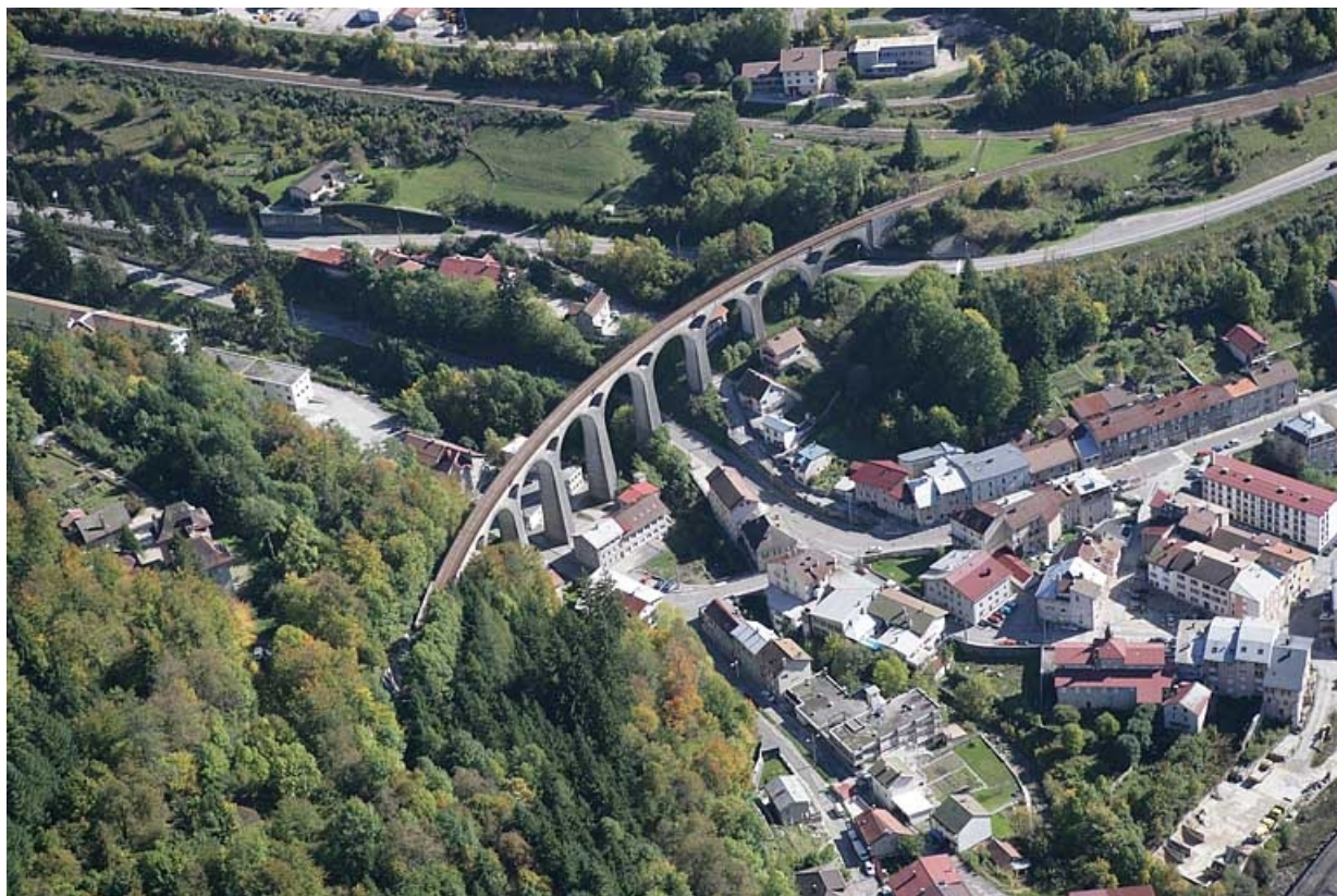
Vue aérienne rapprochée, depuis l'ouest.
