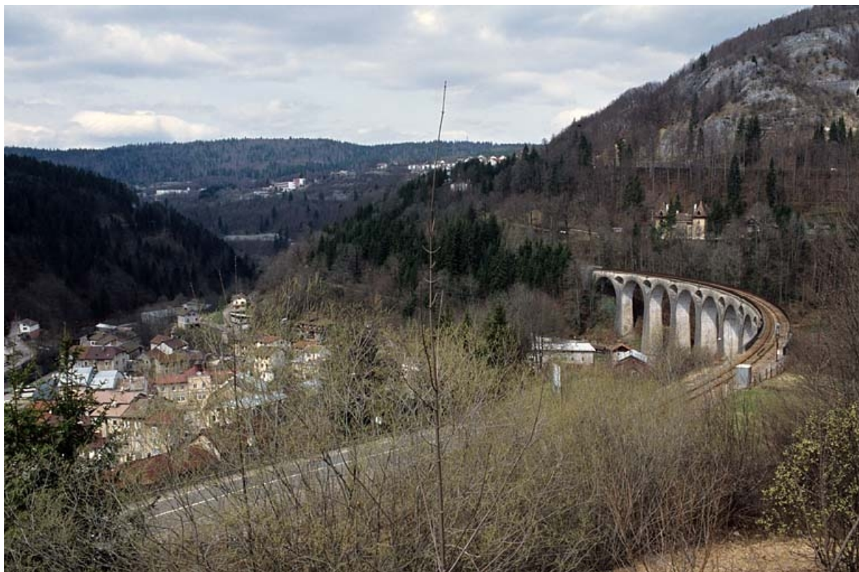
Vue d'ensemble du viaduc et de la vallée de la Bienne, depuis l'est. 39, Morez rue de la République
