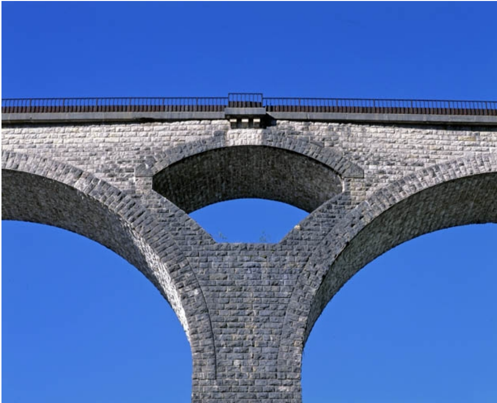
Pile avec voûte d'élégissement et refuge.
