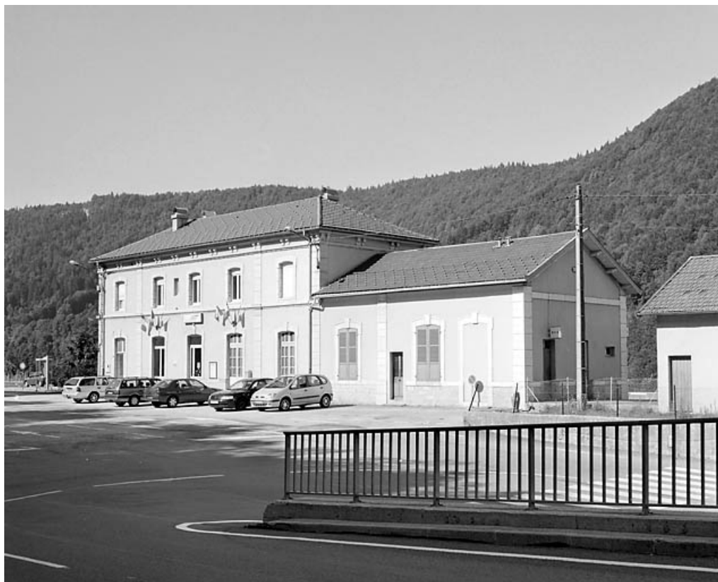
Bâtiment des voyageurs : façade antérieure, de trois quarts droite.
