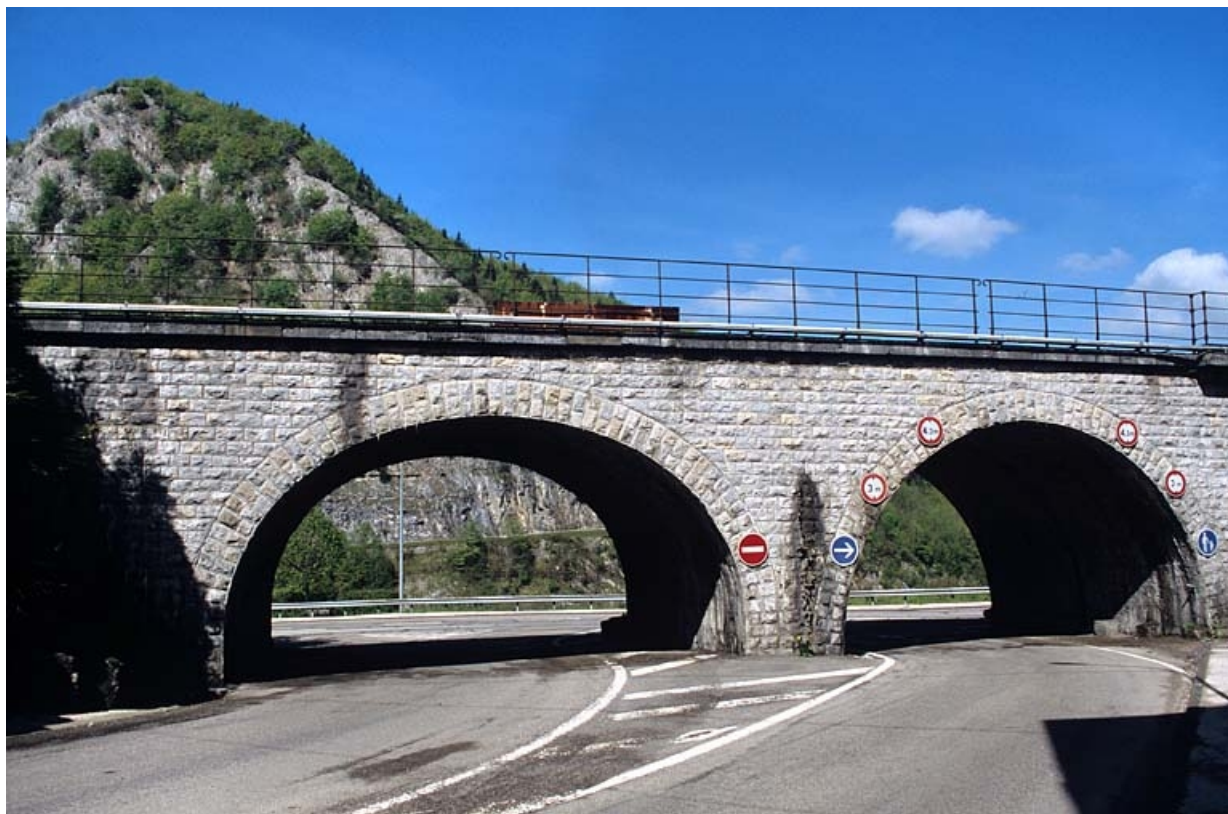
Élévation occidentale : arches enjambant la rue.
