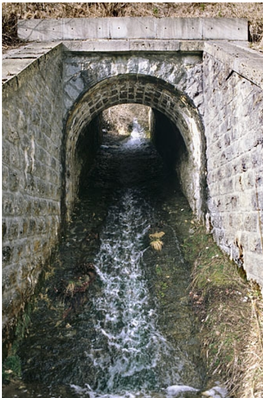
Pont : vue d'ensemble, depuis le sud (aval).
