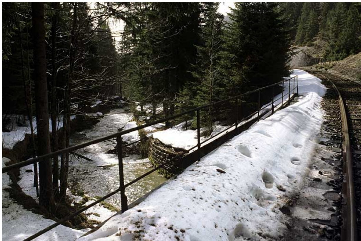
Garde-corps sud (aval) et ruisseau de l'Evalude canalisé.
