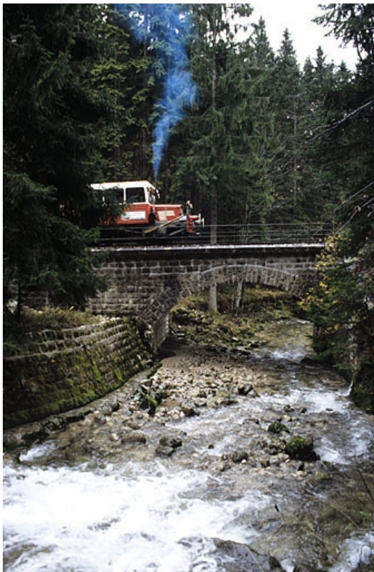
Élévation nord (amont), avec draisine.
