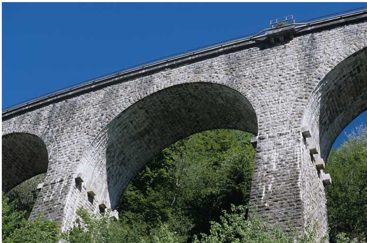
Une arche, vue en contre-plongée.
