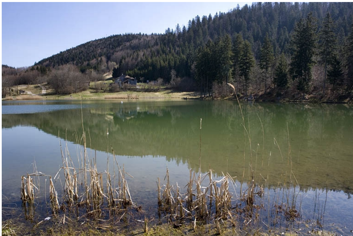
Réservoir : vue d'ensemble, depuis l'ouest.
