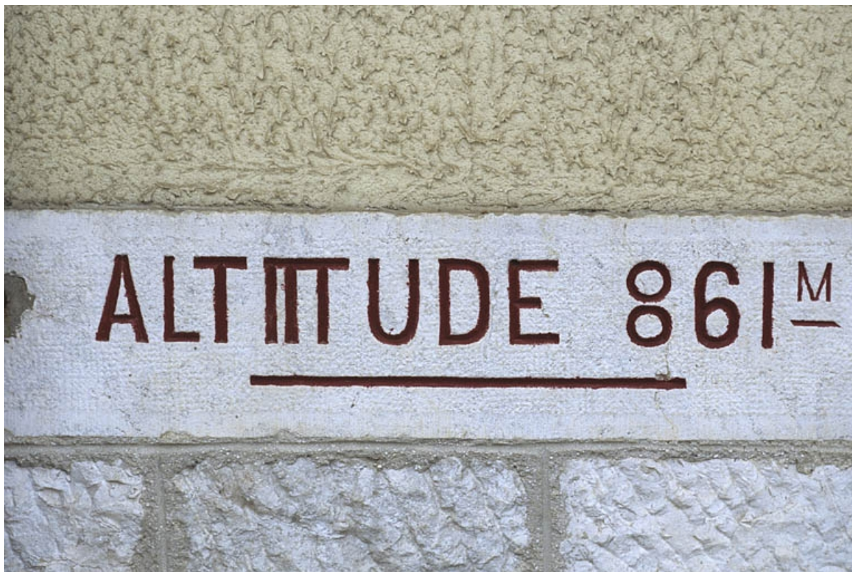
Bâtiment des voyageurs : inscription altimétrique.
