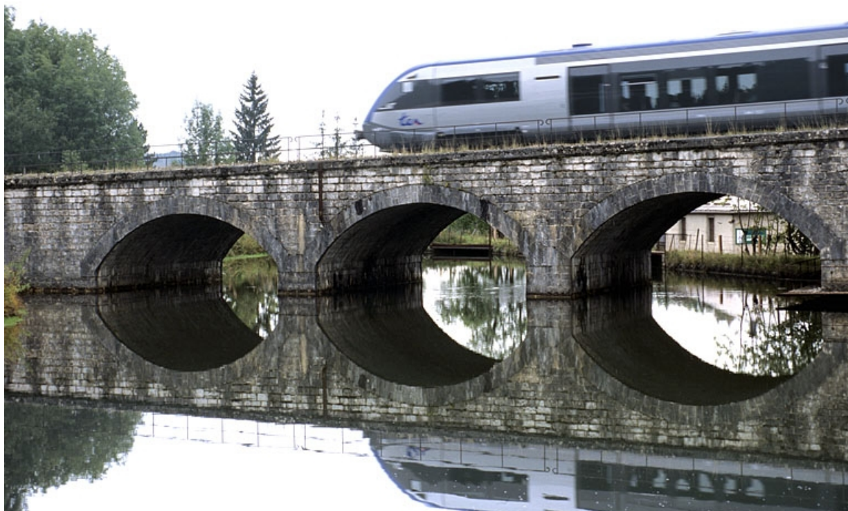
Passage sur le viaduc d'un autorail X 73500 venant d'Andelot-en-Montagne. 39, Morbier route Blanche
