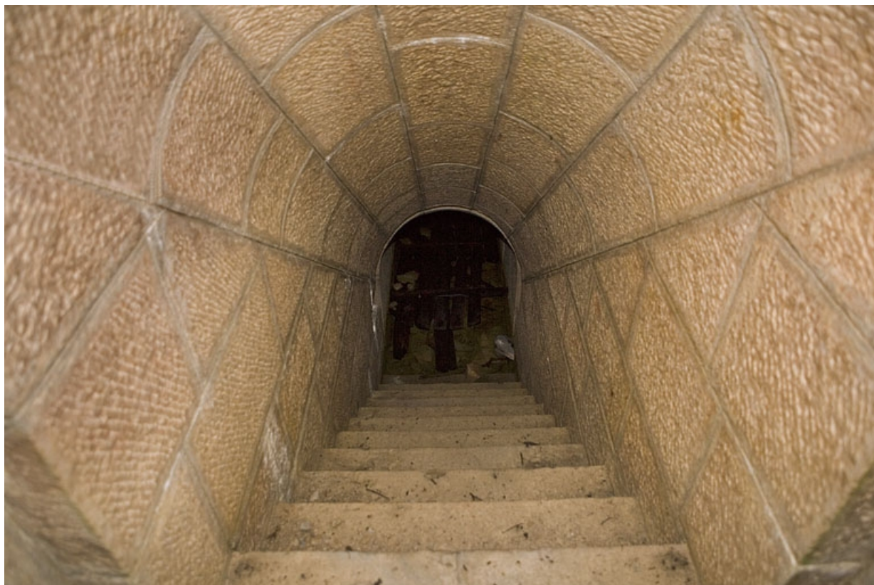
Chambres de mine centrale : escalier.
