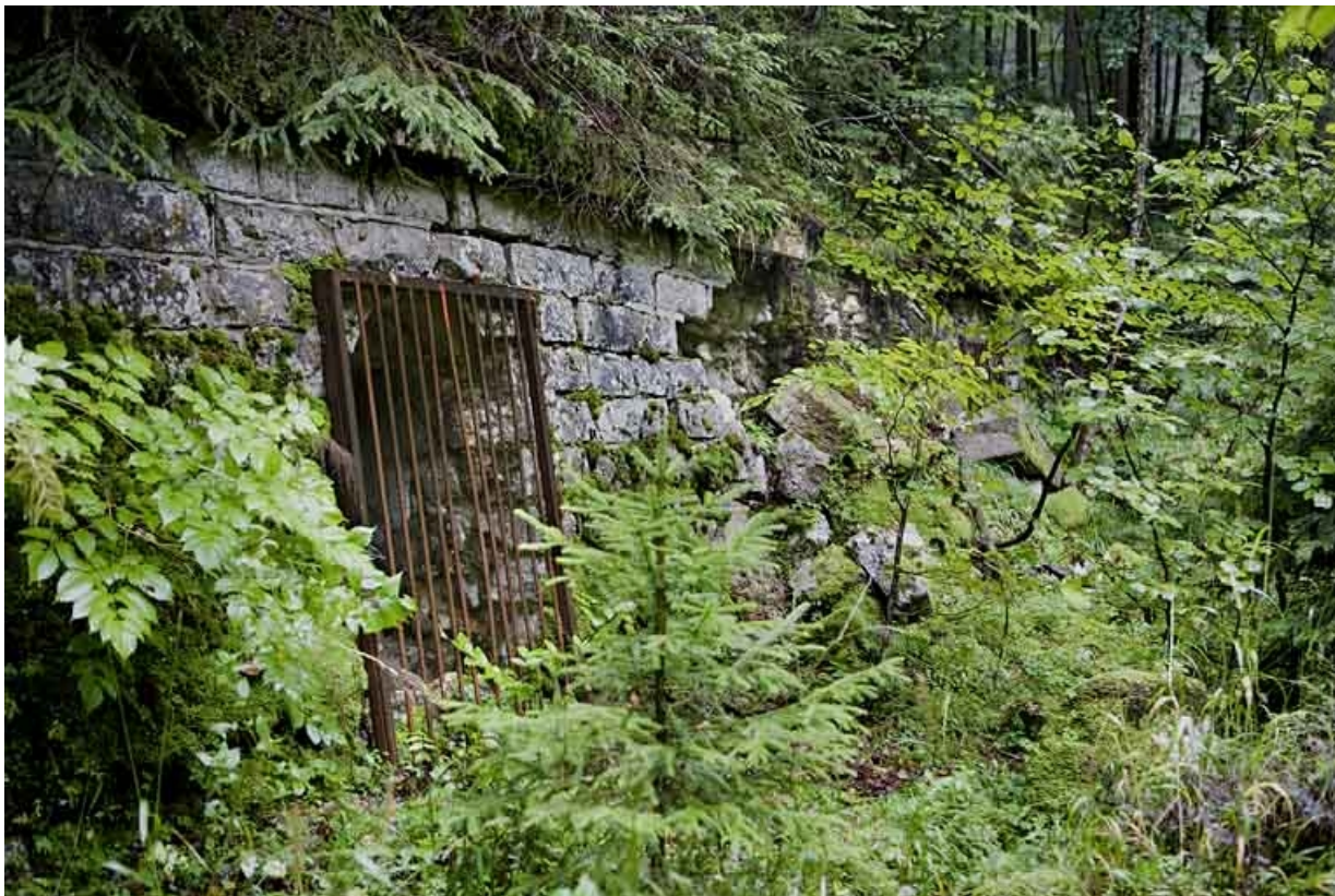
Chambres de mine : vue d'ensemble de l'entrée des galeries centrale et sud-ouest.
