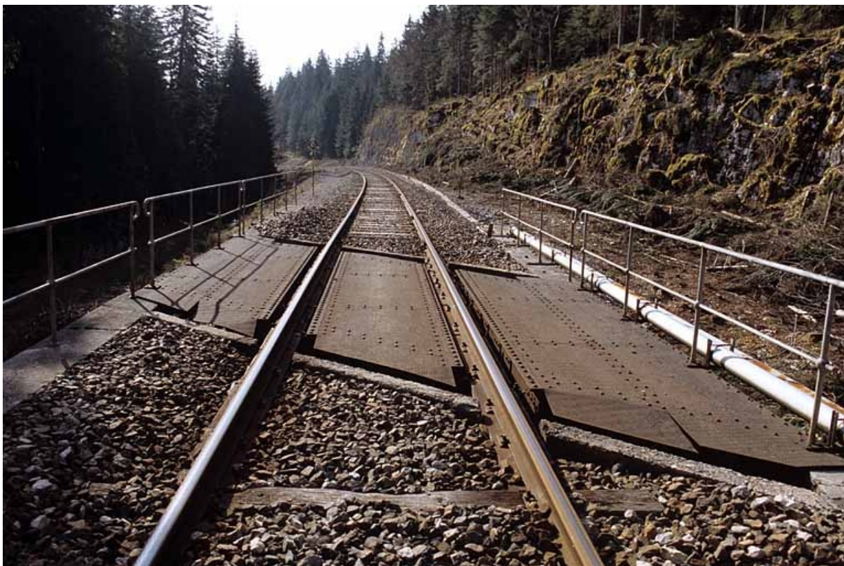
Tablier métallique, depuis la voie côté Andelot-en-Montagne. 39, Saint-Laurent-en-Grandvaux, lieudit : la Forêt de la Joux devant
