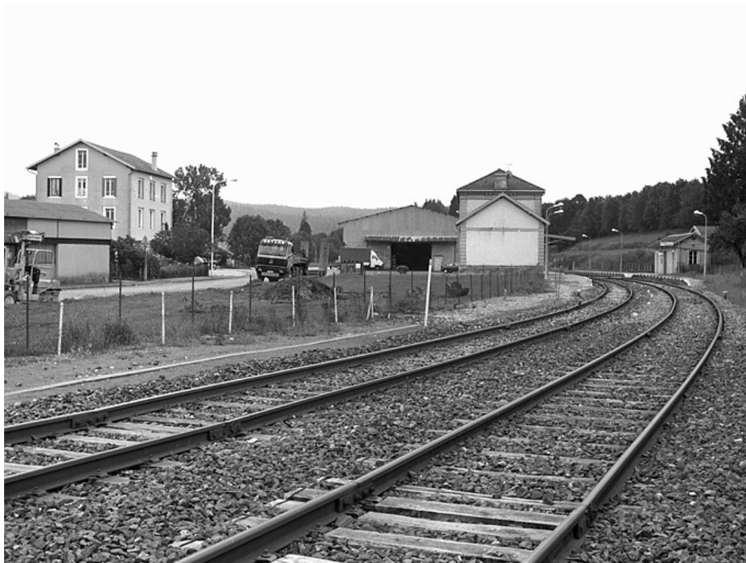
Vue d'ensemble, depuis le nord (côté Andelot-en-Montagne).
