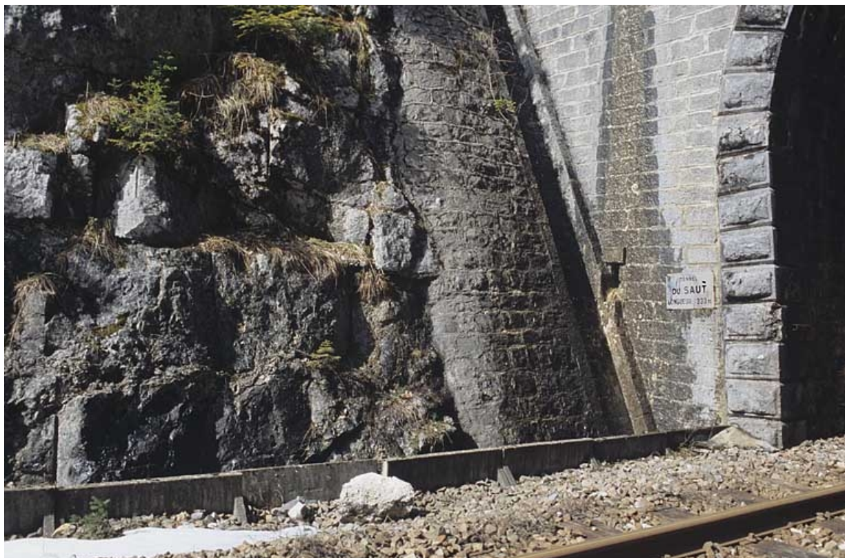
Tête côté La Cluse : descente d'eau, chantepleure et caniveau (détail). 39, La Chaumusse, lieudit : la Vie de la Serre
