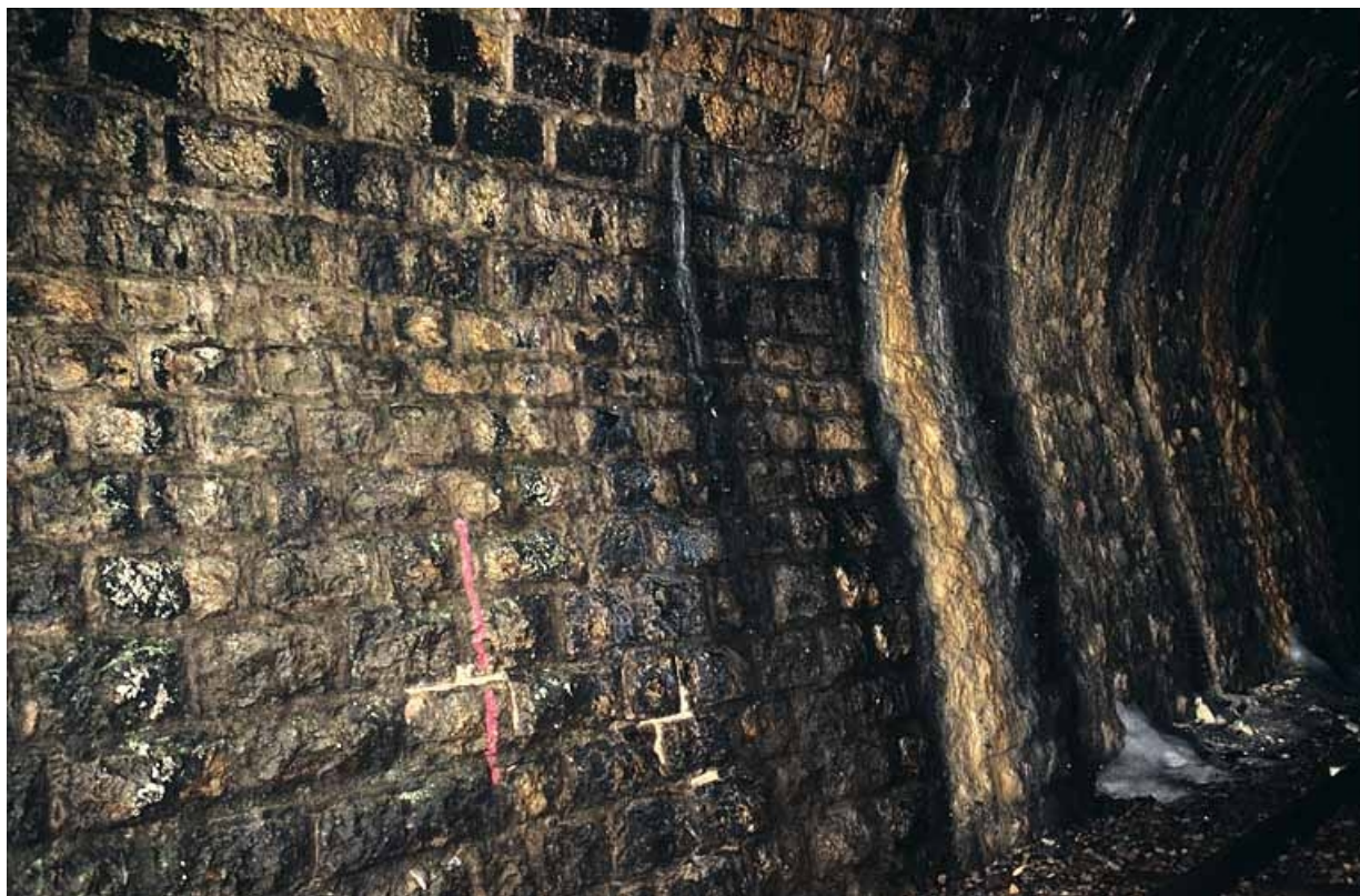
Intérieur (côté La Cluse) : appareil à bossages du mur et voile de calcite.
