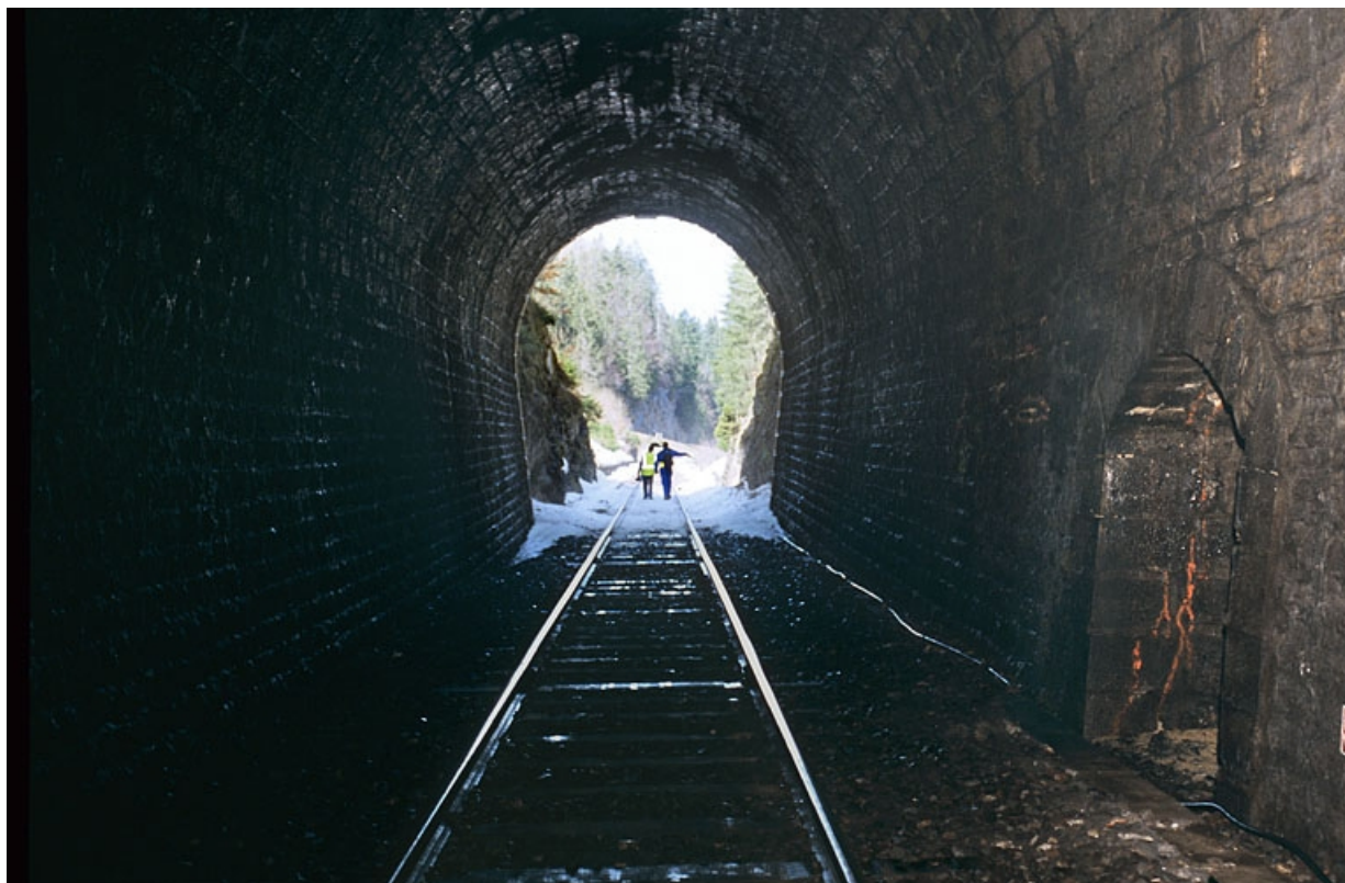
Intérieur (côté Andelot-en-Montagne) : tête et refuge.
