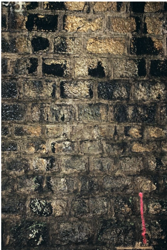
Intérieur : détail du changement d'appareil entre piédroit et voûte.
