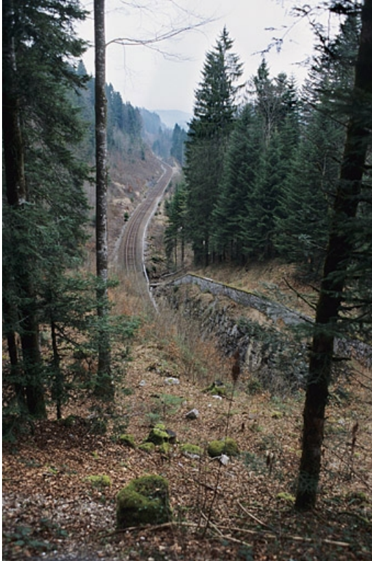
Tranchée et mur de protection côté Andelot-en-Montagne.
