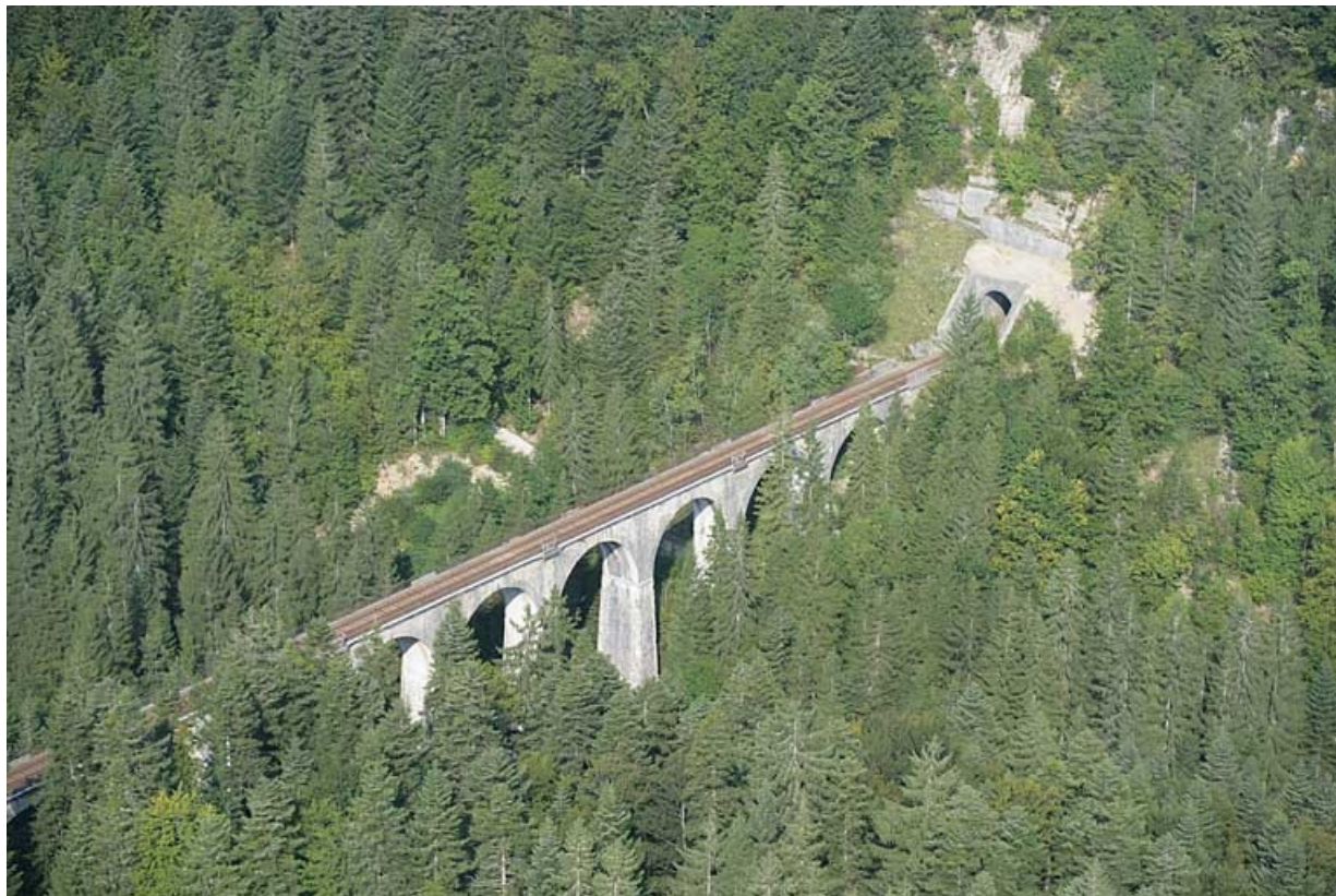
Vue aérienne du tunnel et du viaduc, depuis le sud-est.
