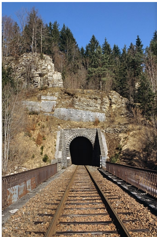
Tunnel : tête du côté La Cluse.
