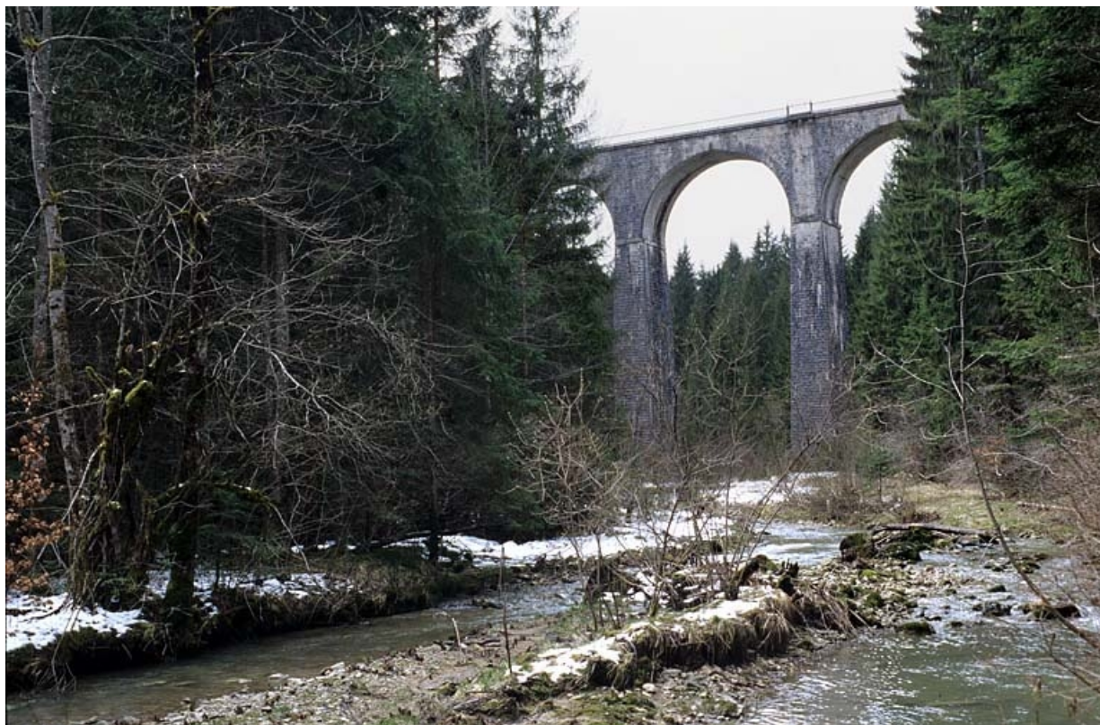
Viaduc : vue d'ensemble, depuis le fond du vallon au nord-est.
