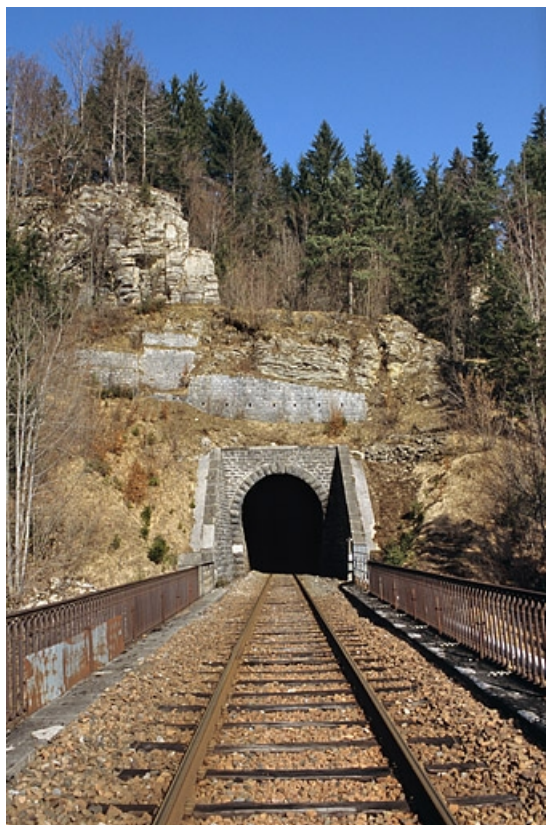
Tunnel : tête du côté La Cluse.
