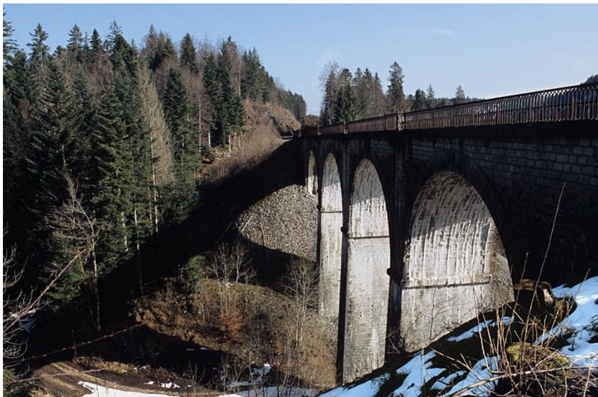
Élévation occidentale vue en enfilade, depuis le côté La Cluse.
