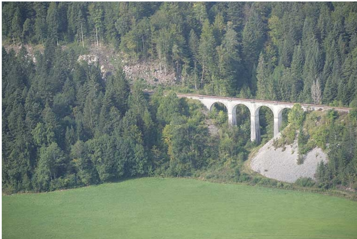
Vue aérienne, depuis le nord-est.
