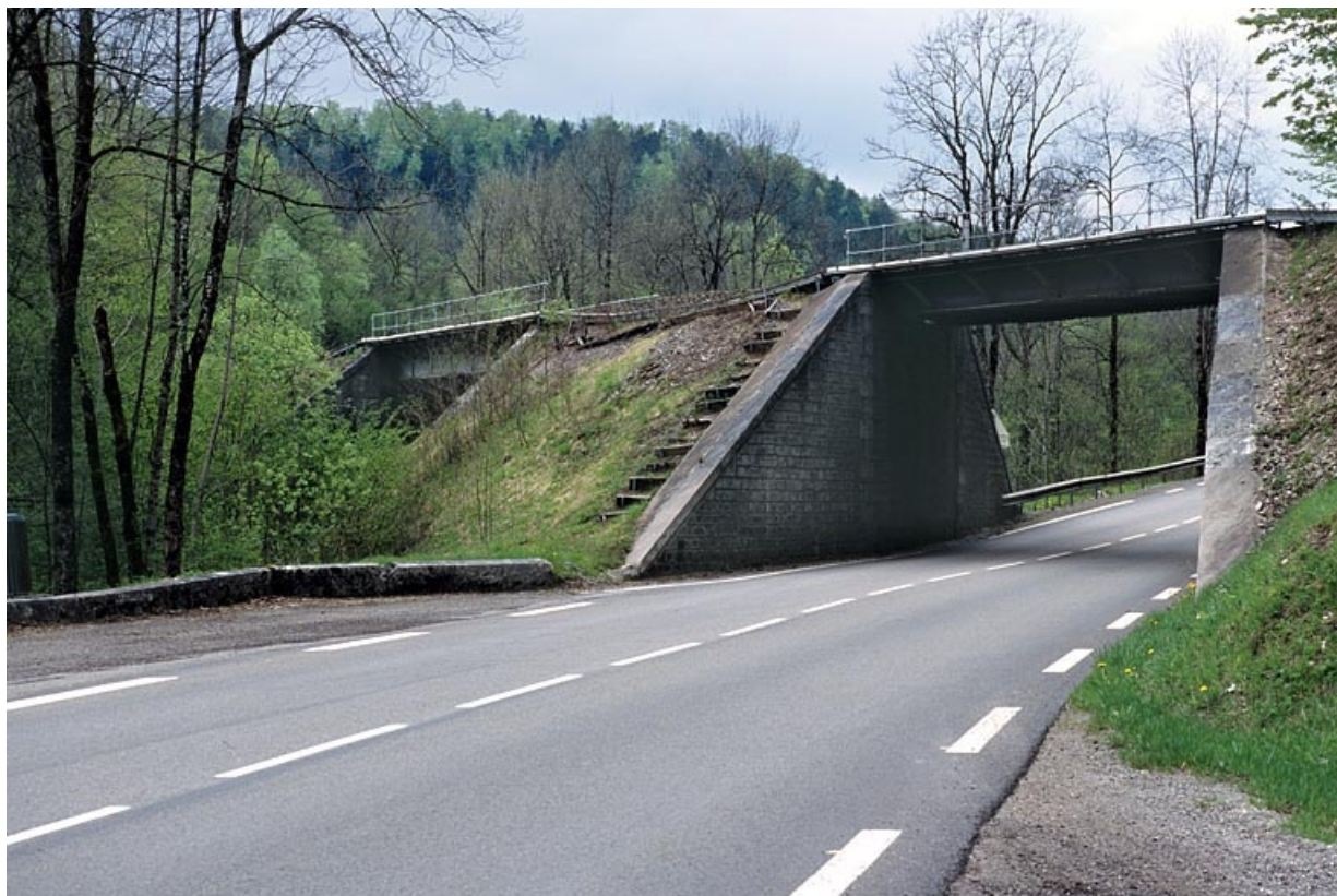
Pont sur la route nationale n° 5 : vue d'ensemble, depuis le côté Andelot-en-Montagne 39, Chaux-des-Crotenay R.N. 5, lieudit : les Belettes
